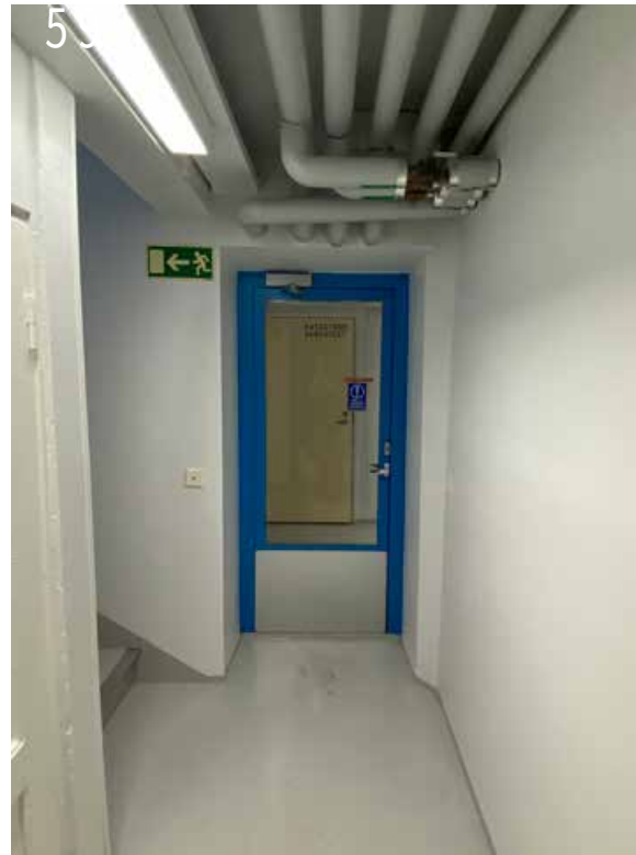
58 Pukutilojen pintamateriaalit ovat vuosien saatossa vaihtuneet.
