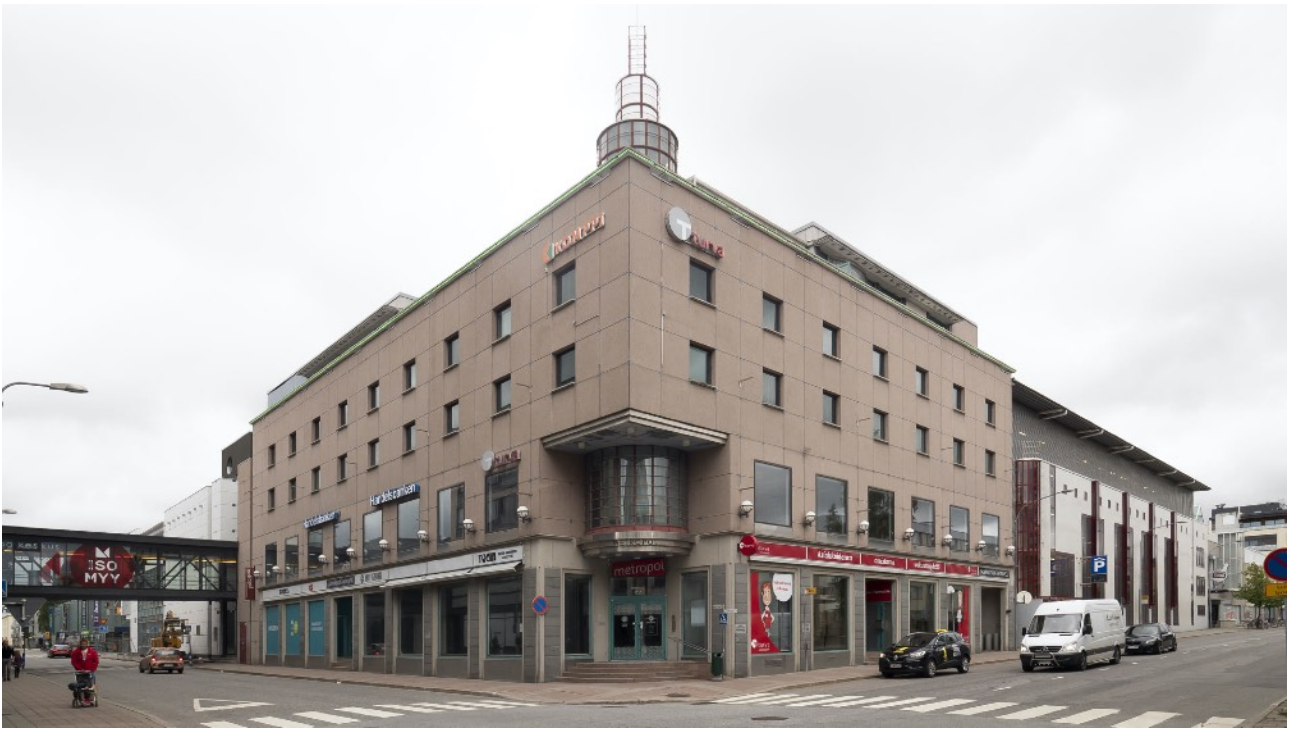
Kiinteistö Oy Torikatu 29 ja kuvassa oikealla pysäköintitalo.
