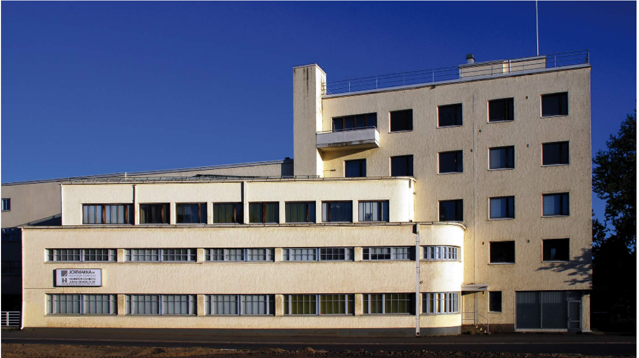
SOK:n konttori- ja varastorakennus.
