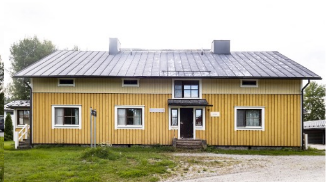
Pienet kuvat: Hyvärilän alueen muita rakennuksia. Vasemmalla ylhäällä entinen navetta. Ylhäällä oikealla vanha rihi. Alhaalla vasemmalla niin sanottu Rantatupa. Alhaalla oikealla Pehtooritalo.
