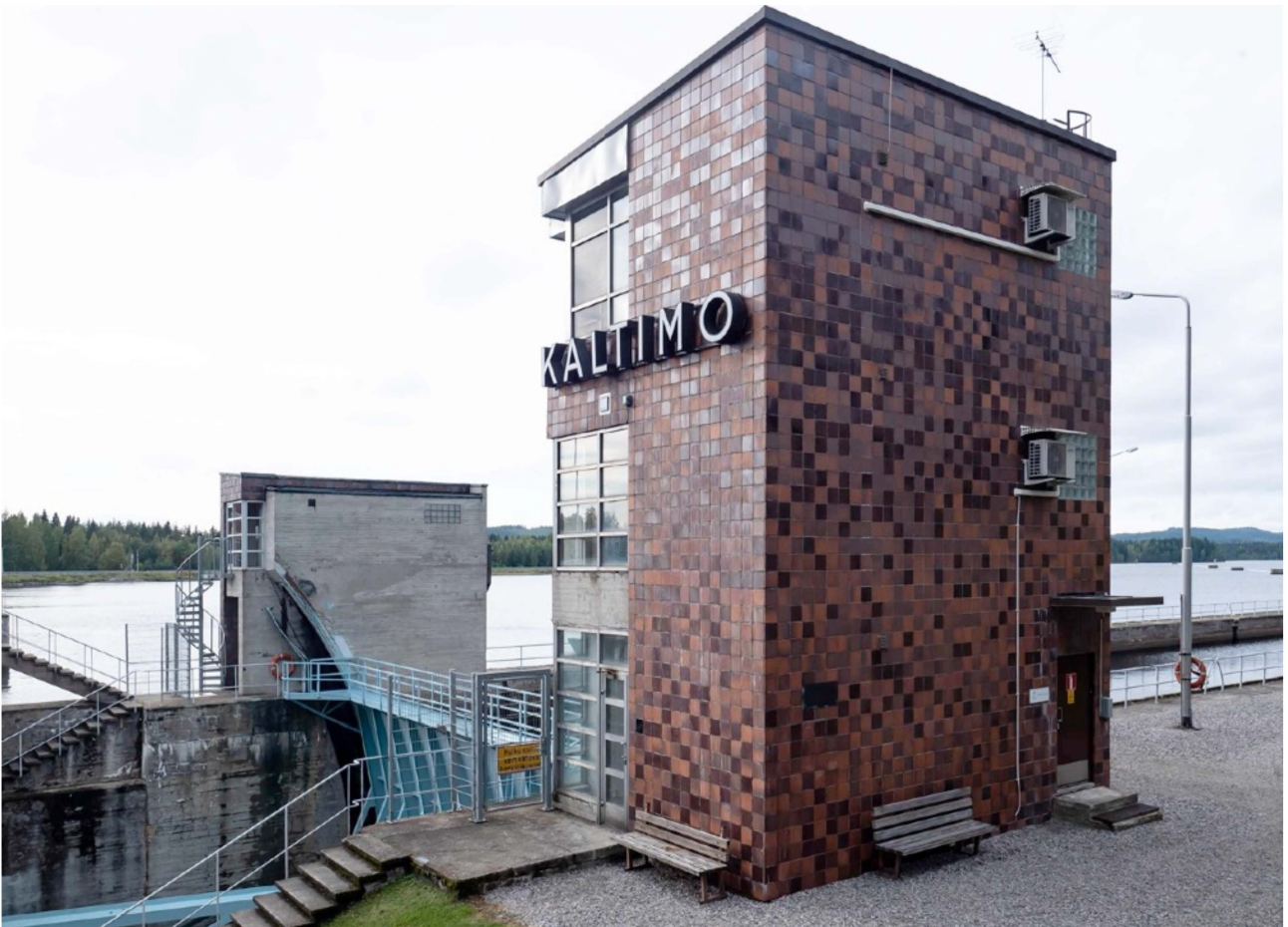
Kaltimon voimalaitoksen suunnittelivat arkkitehdit E. Kråkström ja A. Korhonen.
