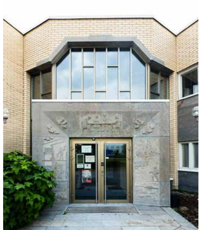
Juuan kunnantalons näyttävä vuolukivin kehystetty pääsisäänkäynti.
