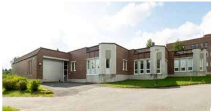
Ilomantsin kunnantalon erillinen kirjastorakennus valmistui 1987.
