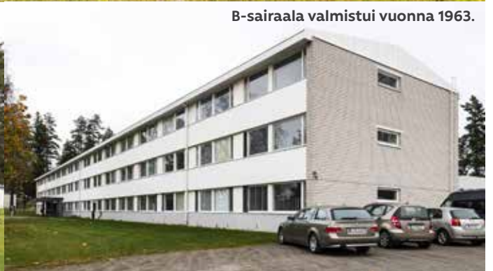
Rakennus avo-osastoille valmistui vuonna 1951.
