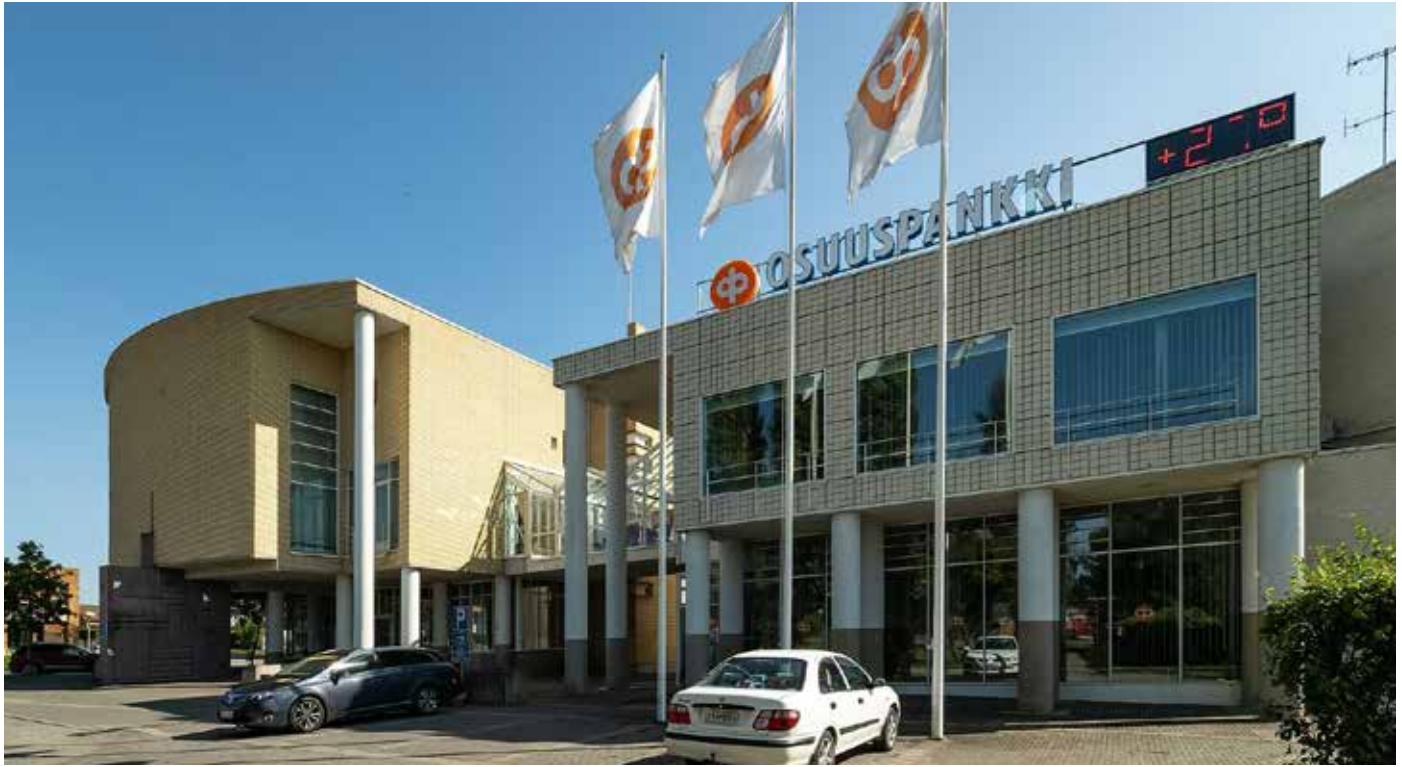
Rääkkylän kunnatalon pääjulkisivua rytmittävät useat massiiviset pylväät.
