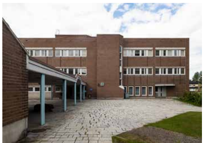
Sammonkadun puolella sijaitsee Valtion virastorakennus.
