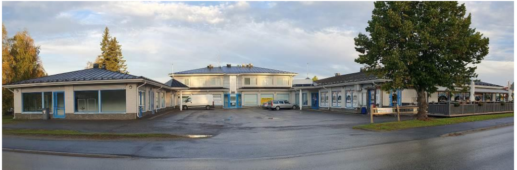
Kuva 4 Muutosalueen rakennus eri puolilta kuvattuna (Kuvat: Kimmo Mustonen 22.9.2023)
