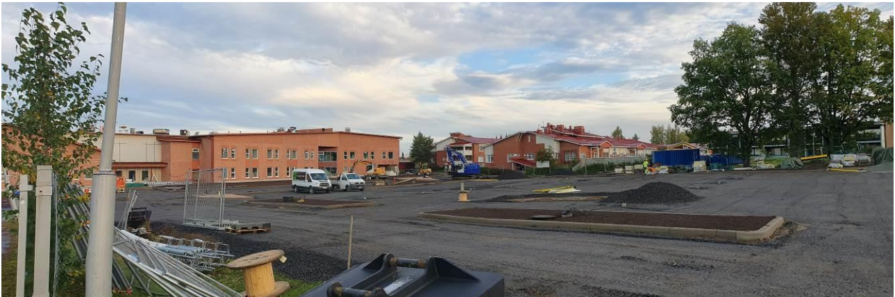
Kuva 7 Muutosalueen pohjoispuolella pysäköinti- ja pihatyöt käynnissä syksyllä 2023 (Kuva: Kimmo Mustonen 22.9.2023)
