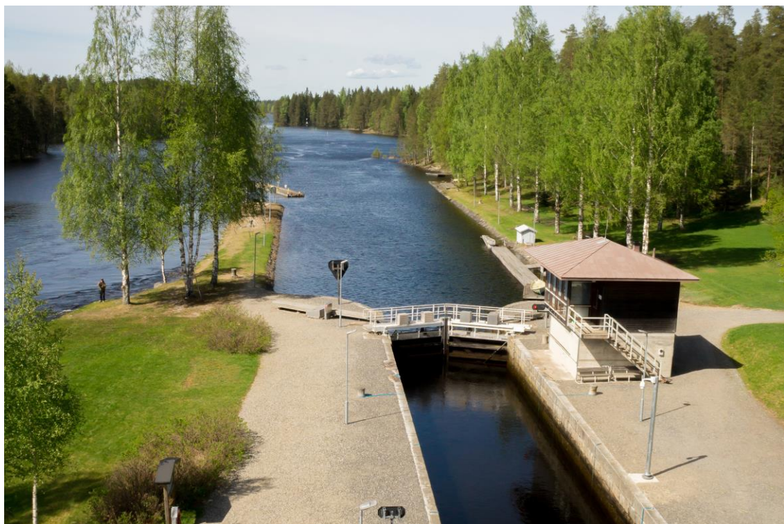
Kuva 20. Karvion kanavan pohjoinen sulku ja valvomorakennus (lähde: Metsähallitus / Vesän ilmakuva).
