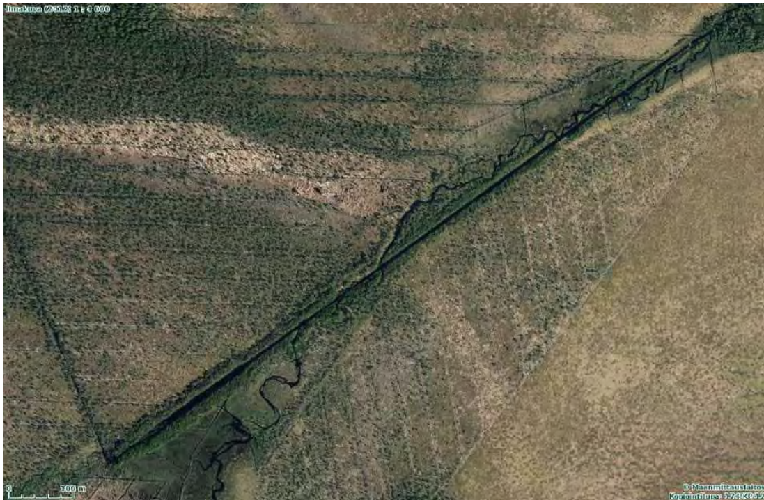
Kuva 4 Ilmakuva Niemijoen alueelta. Kuvassa keskellä näkyy Niemijoen ”päälle” kaivettu oikaisu-uoma. (ei mittakaavassa)
