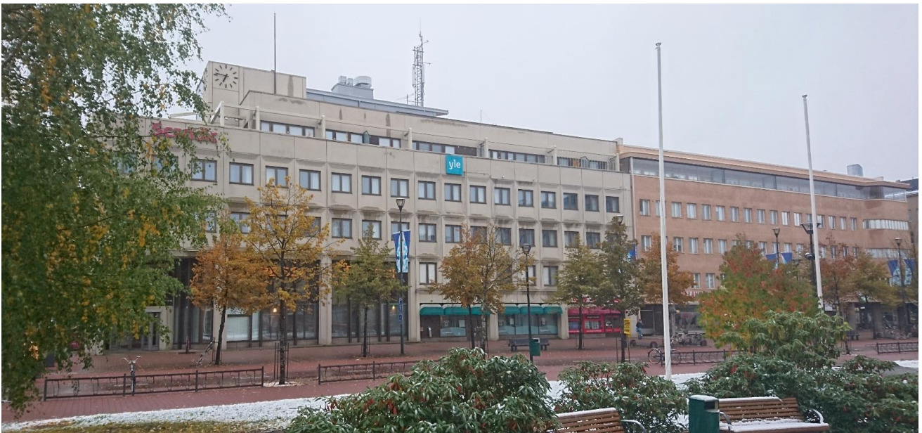
Kuva 2: Kuva Siltakadun puoleisesta julkisivusta (10/2019)
