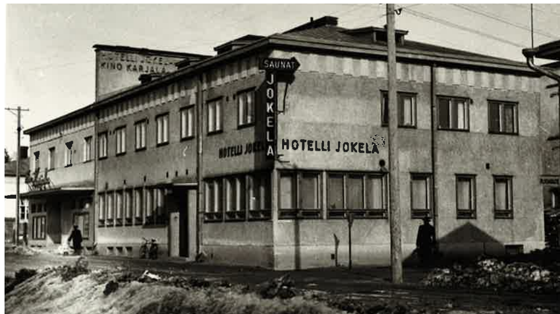
Julkisivu Niskakadulle, jossa näkyy vuonna 1941 tehty toisen kerroksen ikkunamuutos elokuvasalin kohdalla ja rapattu julkisivu, jota kiertää koristenauha räystäään alla. Joensuun kaupunginarkisto.
