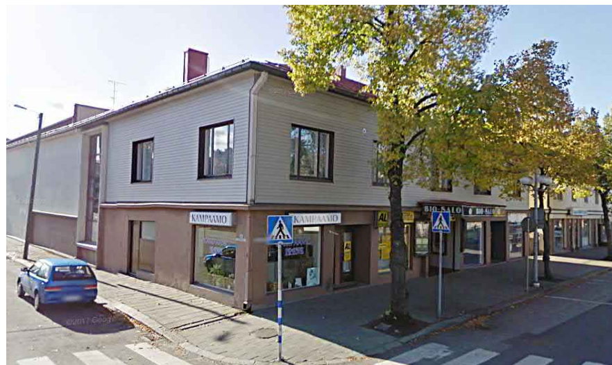
Bio Salo, Helsingintie 11, Salo. Kuvakaappaus Google Street View.
