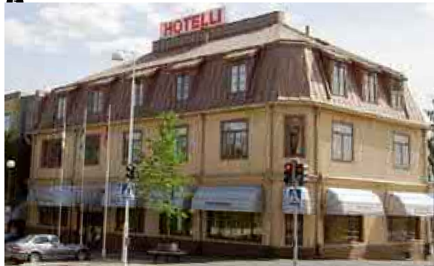
Iisalmen seurahuone, Savonkatu 24, Iisalmi. Kuva Iisalmen ydinkeskustan arvokkaat rakennetut kulttuuriympäristöt, kohde 235.
