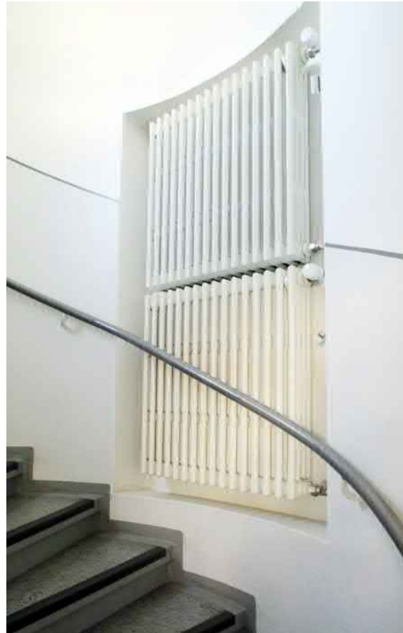
Kapeassa porrashuoneessa pattereille on rakennettu oma syvennys.
