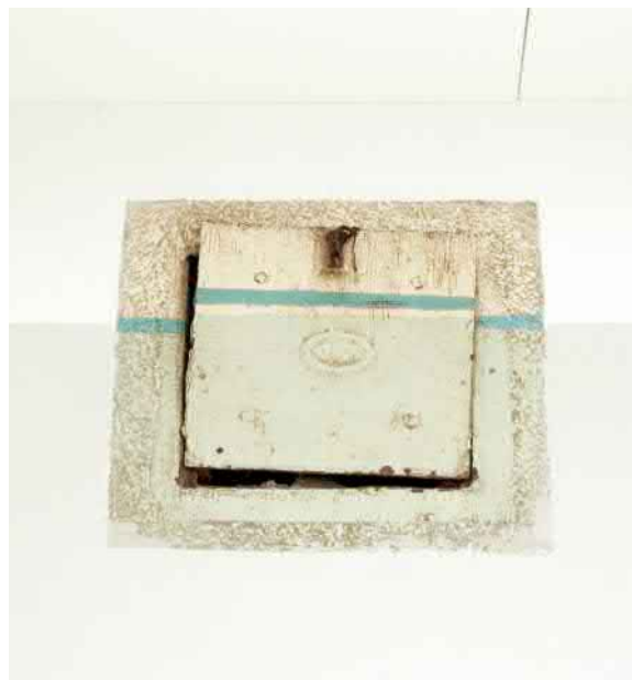
Ilmanvaihtoluukun kohdalle on vuoden 2009 muu- tostöissä jätetty näkyviin edellinen maalikerros.
