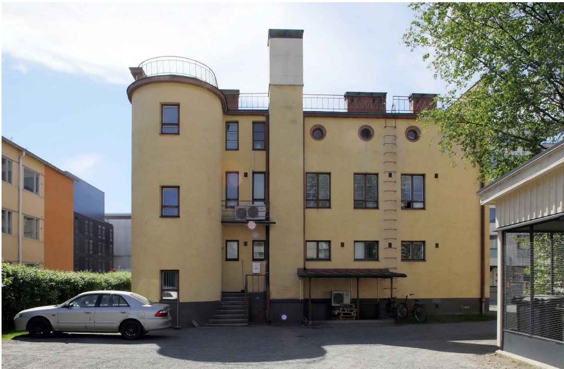
Ullakon ikkunat ovat pyöreitä. Piipun alaosassa on metallinen huoltoluukku sisäpihan puolella ja yläosa on pellitetty. Piipun oikealle puolelle on rakennettu myöhempi katos ja sisäänkäynti. Sisäpihan puolella ei ole koristeluita kuten hammaslistaa - joskin räystäskin on eri korolla. Ikkunajako on alkuperäinen. Parveke ja talousportaan sisäänkäynti ovat alkuperäisiä.
