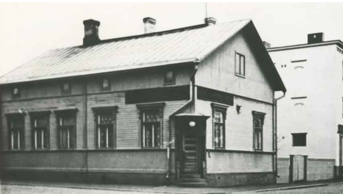
Jokelan paikalla ollut puurakennus, joka osin purettiin ja muokattiin nykyiseksi rakennukseksi. Valokuvaus aika 1937-1939. Reprokuva Pirjo Jantunen 1972, Pohjois-Karjalan museo.
