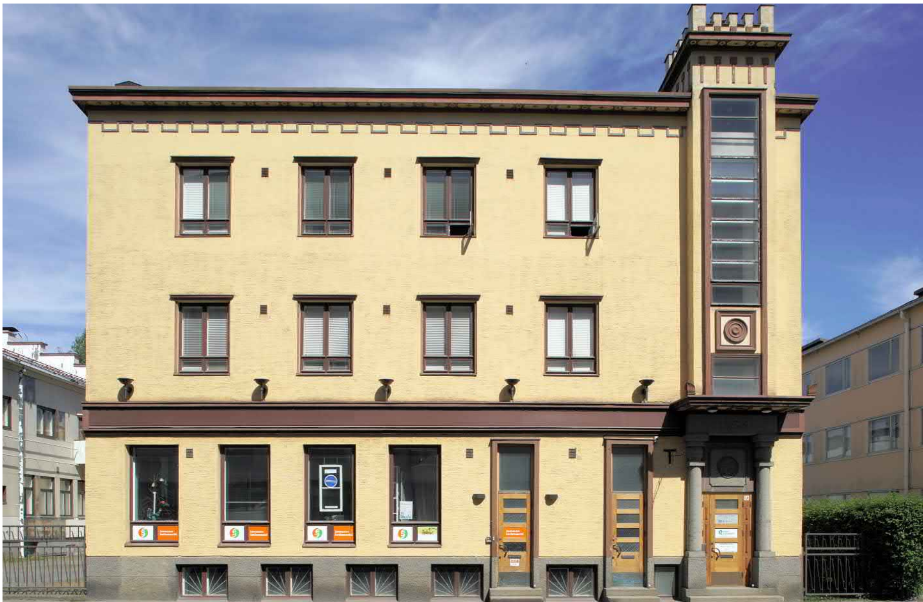
Inarin talon katujulkisivu kesällä 2018. Ei ole tietoa, vastaako nykyinen julkisivuväriytyys alkuperästä. Asuinkerrosten ikkunat ovat alkuperäisiä, liikehuoneistojen ikkunat on uusittu metallirakenteisina. Julkisivuun on lisätty valaisimet. Kokonaisuutena julkisivu on säilynyt hyvin.
