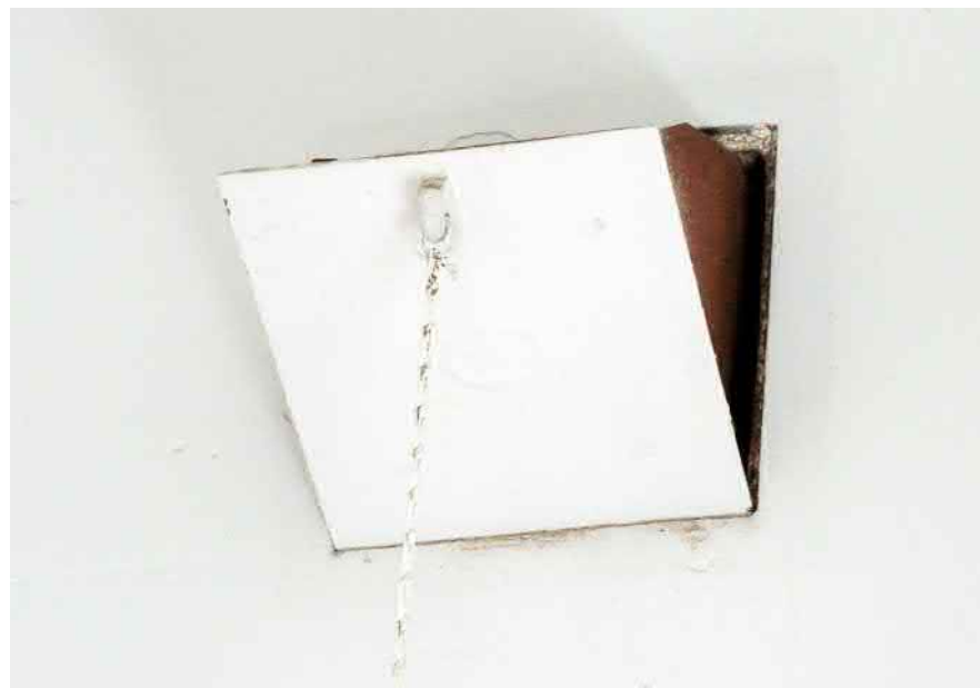
Alkuperäinen raitisilmaluuk- ku on edelleen käytössä.
