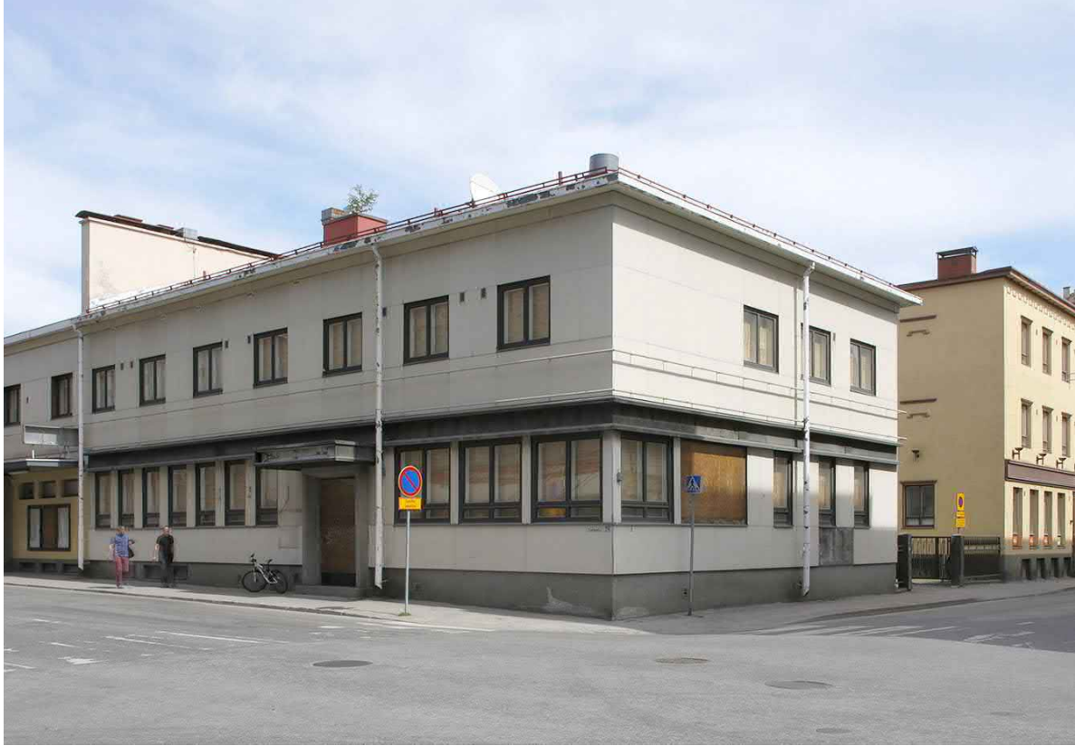
Rakennuksen länsikulma nykytilassa. Ikkunat on peitetty sisäpuolelta vanerilevyin eikä mainoslaitteita ole.
