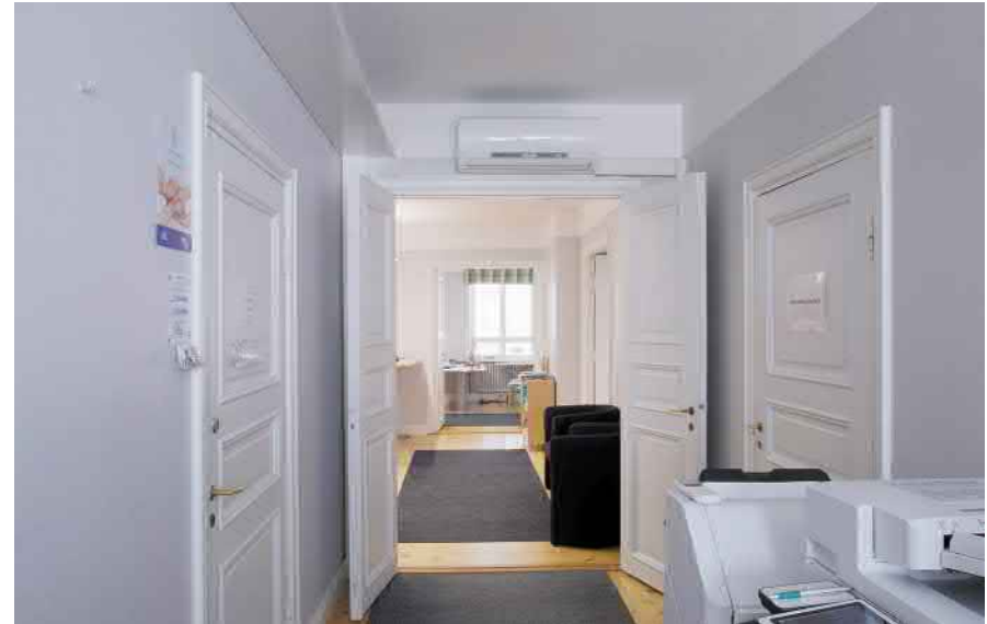
Entisen asunnon, nykyisen toimiston puupeiliovet ovat hyvin säilyneet, samoin vuorilistat.
