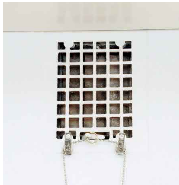
Alkuperäinen valurautainen poistorilä on edelleen käytössä.
