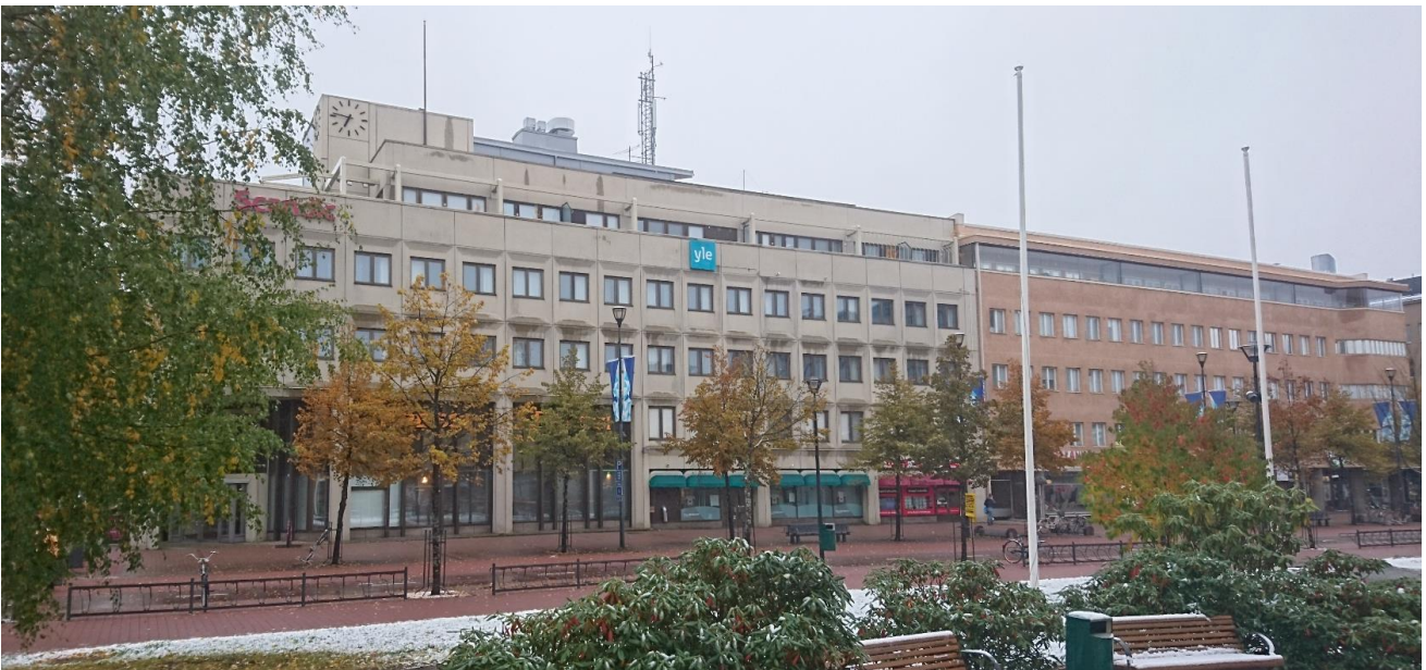
Kuva 2: Kuva Siltakadun puoleisesta julkisivusta (10/2019)
