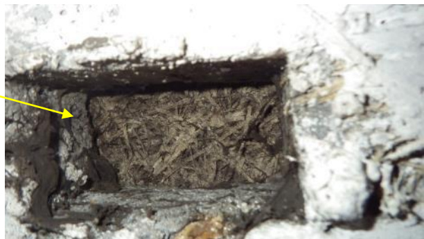
Kuva 5.18.6. Öljysäiliötilan holvissa yhteys välipohjan eristekerrokseen.
