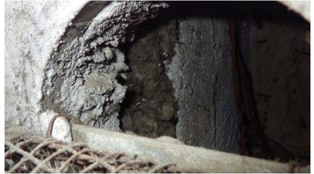
Kuva 5.2.8. Perusmuurin sisäverhousmuurauksen ja perusmuurin välinen eriste on näkyvissä tuuletusventtiilin ilma-aukosta (keittiön varasto).
