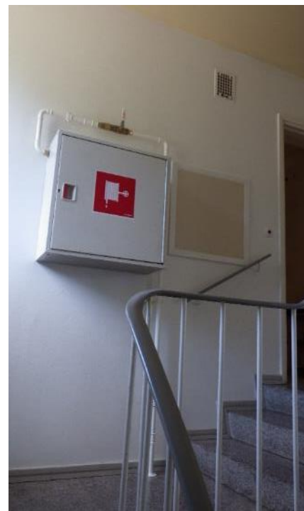
Kuva 6.14. Porrashuoneessa oleva paloposti.
