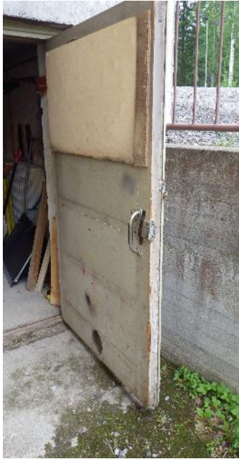
Kuva 5.11.3. Pienen autotallin ovi.
