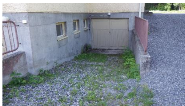
Kuva 5.1.4. Autotallin oven eteen kertyvät vedet ohjataan oven edessä olevaan sadevesikaivoon.
