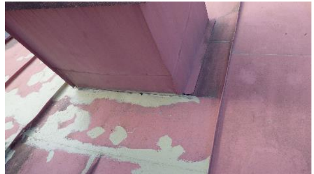
Kuva 5.13.2. Peltikatteen maalipintaa on korjattu ruosteisilta kohdilta.
