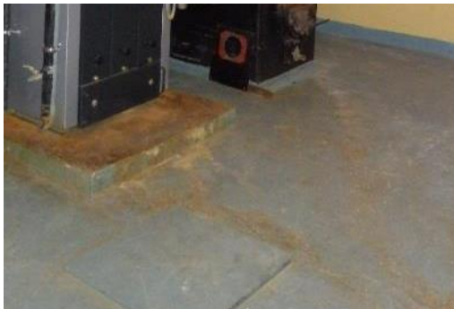
Kuva 5.3.3. Alapohjarakenne AP1, kattilahuoneessa.
