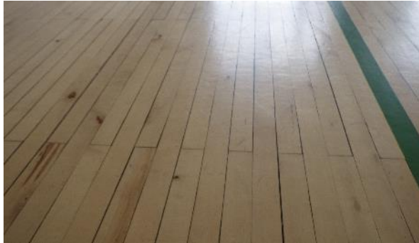
Kuva 5.15.7. Juhlasalin lattiapinnoitteena on lakattu ponttilattia, koivua.
