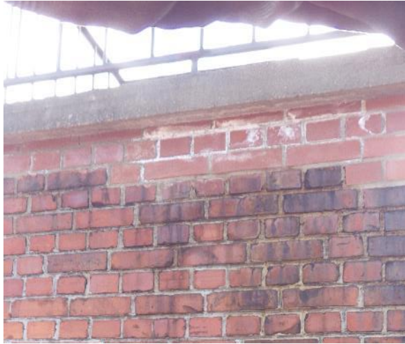
Kuva 5.17.3. Keskuslämmityshormin yläpää on korjattu.
