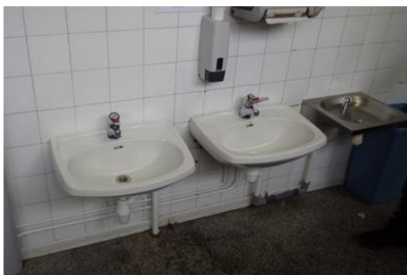
Kuva 6.15. Pesualtaat ovat hyväkuntoisia.
