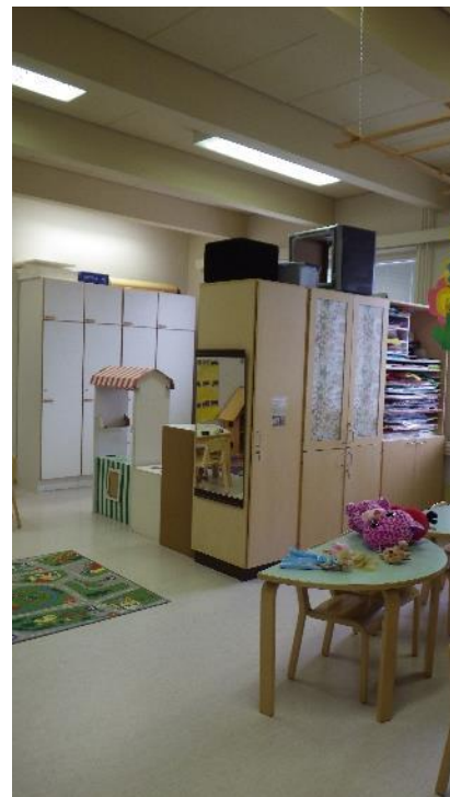
Kuva 5.15.2. Luokan lattiapinnoitteena on muovimatto. Katossa on alkuperäiset akustiikkalevyt.
