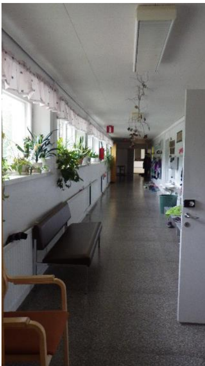
Kuva 5.15.1. Oppilaskäytävän lattiapinnat ovat graniittimosaiikkibetonia. Katossa on alkuperäiset akustiikkalevyt.
