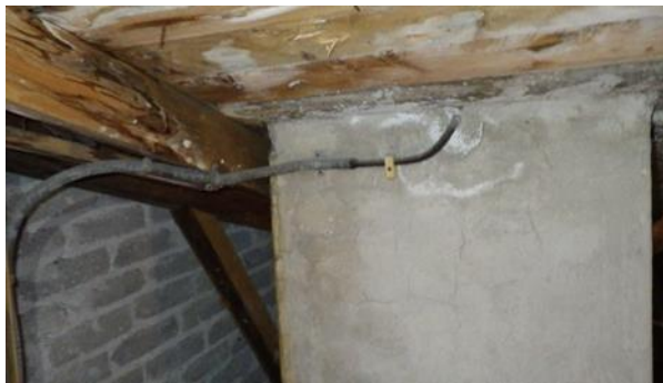
Kuva 5.17.5. Tiilihormi ullakkotilassa on hyväkuntoinen.
