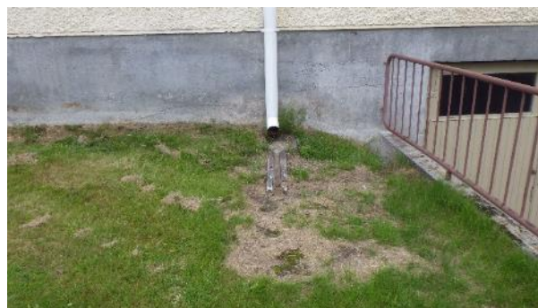
Kuva 5.1.2. Syöksytorvelta tulevat vedet on ohjattu osin betonikourun kautta nurmikkoalueelle.
