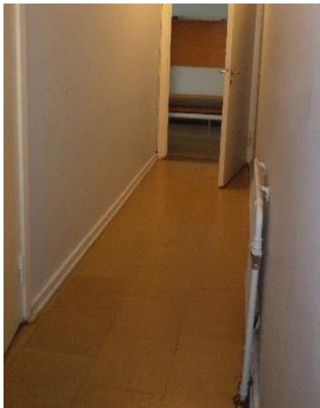
Kuva 5.15.5. 1-kerroksen pukuhuone-tiloissa ja käytävässä on lattiapinnoitteena alkuperäinen vinyylilaatoitus.
