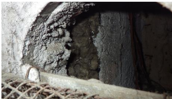
Kuva 5.17.7. Kellarin varaston perusmuurissa olevan ilmanvaihtoaukossa on näkyvissä lämmöneriste.
