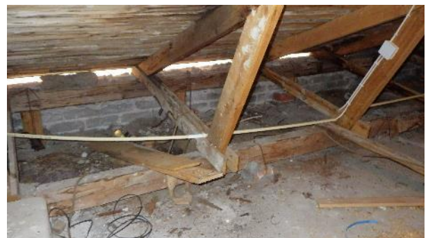
Kuva 5.13.4. Ullakon tuuletus tapahtuu räystäsrakojen kautta.
