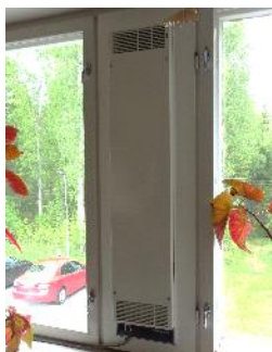
Kuva 6.5. Opettajainhuoneen Hengetär-ilmanvaihtolaite.
