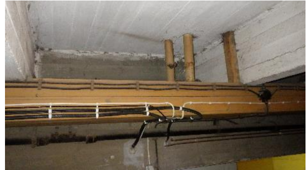
Kuva 5.17.10. Kellarin katonrajassa sijaitsee puura- kenteiset lämpöjohtokotelot.
