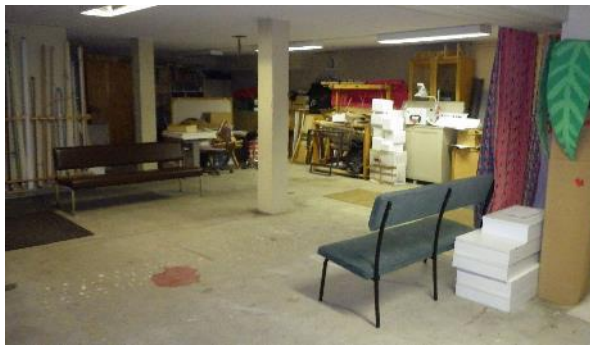
Kuva 5.15.9. Kellarin lattiapinnat on suurelta osin maalaamattomia betonilattioita.
