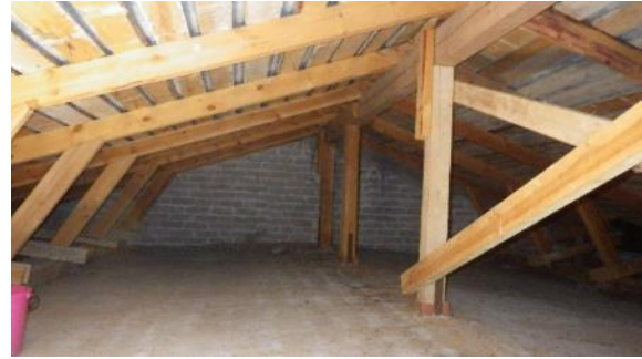
Kuva 5.7.5. Yläpohjarakenne on keskellä rakennusta korkeampi. Palopermanto on hyväkuntoinen.
