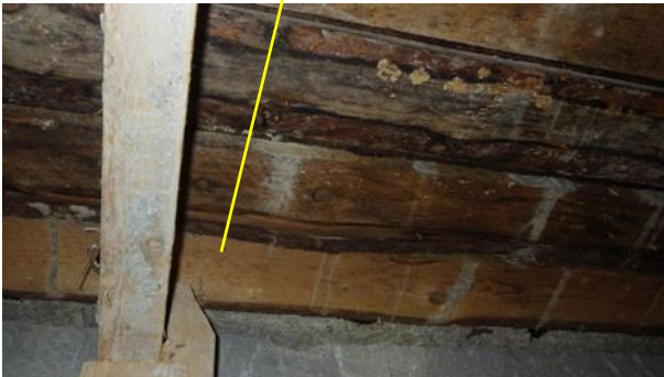
Kuva 5.6.9. Näkyvissä on ylälaatan muottilaudoitukset ja betonipalkin ja ylälaatan välissä oleva lastuvillaeriste.
