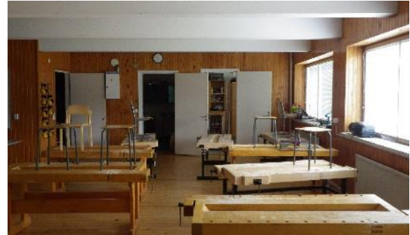
Kuva 5.15.8. Veistosalin lattiapinnoitteena on lakattu ponttilattia, mäntyä ja seinäpinnoitteena on lakattu puupaneeli.
