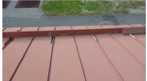
Kuva 5.13.6. Lumiesteet ovat puusoiroja metallikiinnikkeillä.
