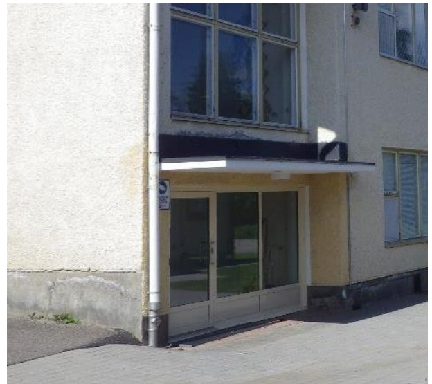
Kuva 5.11.2. Urheilukentän puoleinen ulko-ovi on uusittu v. 2004.
