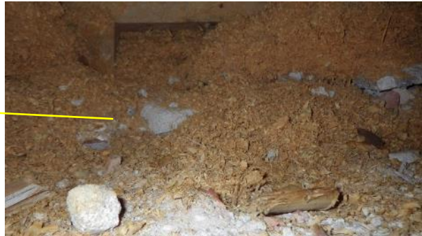
Kuva 5.6.8. Välipohjan eristeenä on puupuru / kutterilastu.
