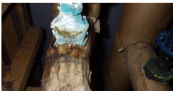
Kuva 6.9. Lämpöjohtoventtiilissä pintahapettumaa.
