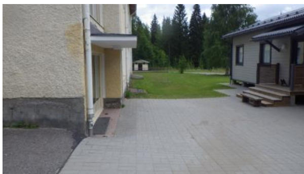
Kuva 5.1.1. Parakkikoulun vastaisilta syöksytorvilta tulevat vedet on ohjattu osin suoraan sadevesiviemäriin.
