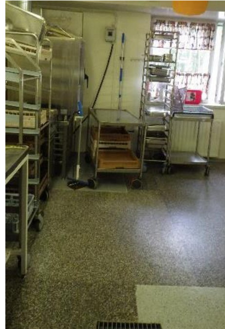
Kuva 5.15.4. Keittiön lattia on graniittimosaiikkibetonia.
