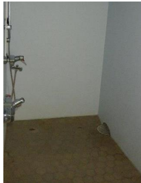
Kuva 5.15.6. Oppilaitten pesutilojen lattiapinnoitteena on alkuperäinen laatoitus. Seinissä on maalattu lasikuitutapetti.
