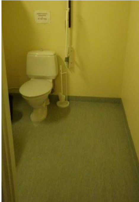
Kuva 5.15.3. Wc:n lattiapinnoitteena on muovimatto, seinät ovat maalattu.
