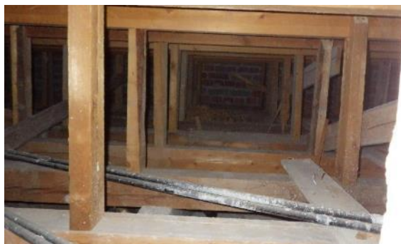
Kuva 5.6.16. 2-kerroksen välipohjan palkkien päällä näkyy näyttämön tukirakenteet.
