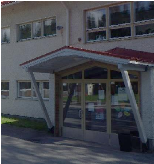
Kuva 5.11.1. Etupihan puoleinen, alkuperäinen puuovi.
