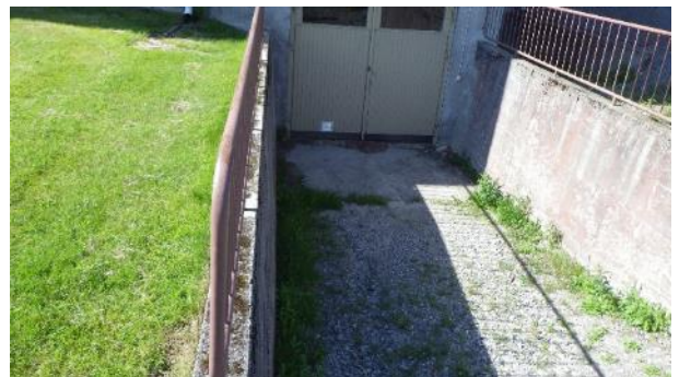
Kuva 5.2.10. Kellarin sisäänkäynnin maanvastainen tukimuuri on rakenteellisesti hyväkuntoinen.
