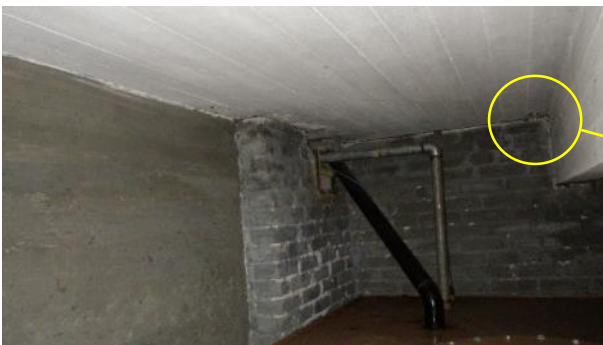
Kuva 5.18.5. Öljysäiliötilan holvissa yhteys välipohjan eristekerrokseen.
