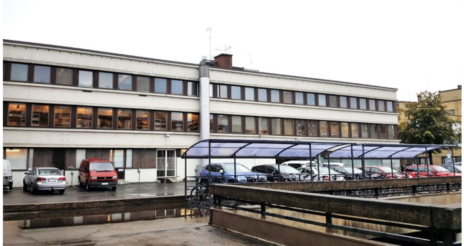
Kuva 4. Näkymä Torikatu 19 sisäpihalta.
