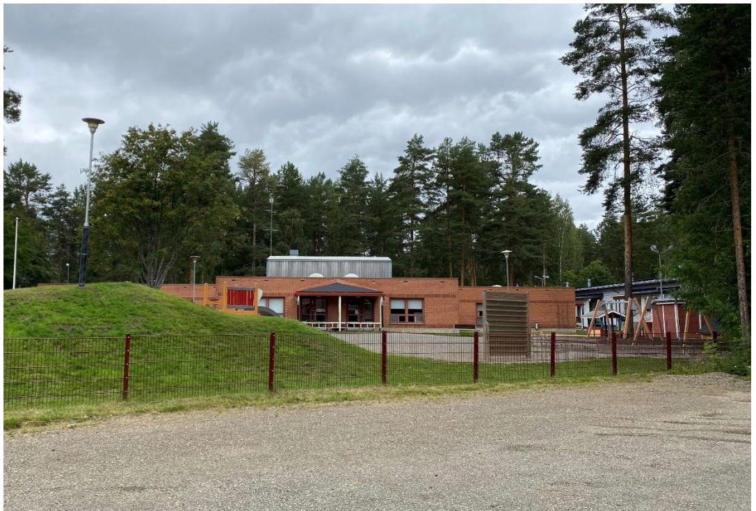
Kuva 2: Päiväkotirakennus Vesikkotien kääntöpaikalta (8/2020)
