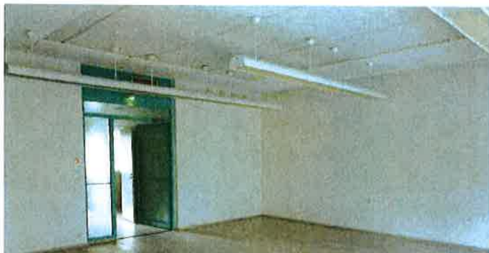
Rantakylän liikerakennuksen liikehuoneistoja, Puronsuunkatu 1 A
