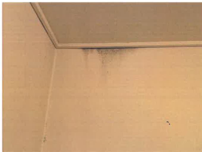
Kuva 17: Siivouskomeron katossa ilmajäljet.
