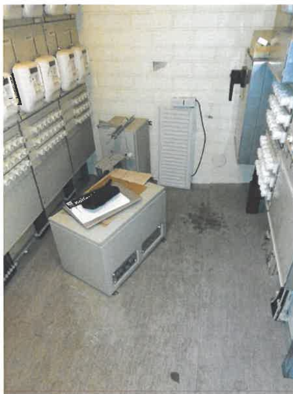
Kuva 18: Sähköpääkeskus
