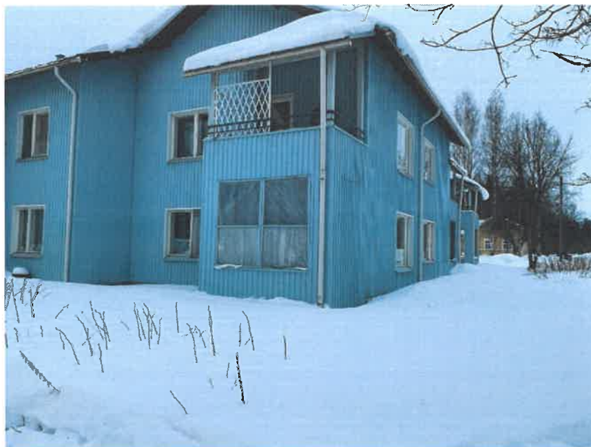
Kuva 6: Puuosat ovat peruskunnossa. Maalipinta haalistunut varsinkin etelä ja länsipuolelta.
