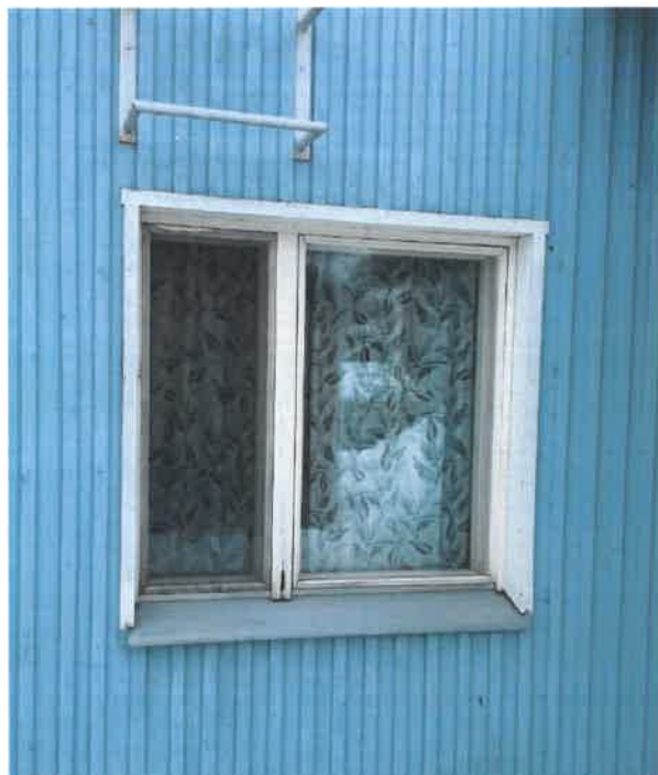
Kuva 7: Ikkunapuitteissa lahovaurioita.
