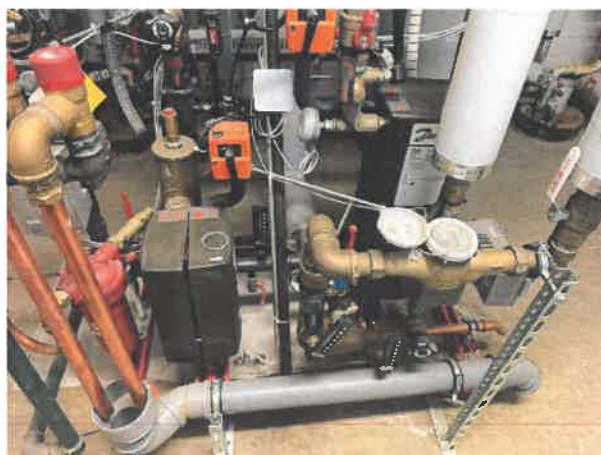
Kuva 13: Nykyinen lämmönsiirrin.
