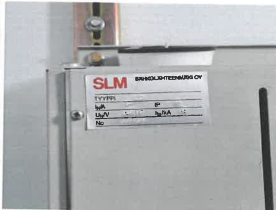
Kuva 41: Pääkeskuksen tyyppikilpi.
