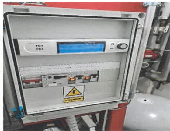
Kuva 28: Keskukseen ohjauspaneeli.
