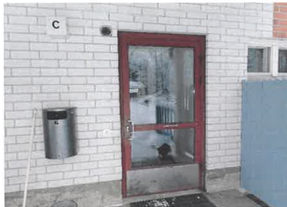
Kuva 9: Ulko-ovien pintakäsittelyssä havaittiin kulumista ja pinnoitteen irtoamista.
