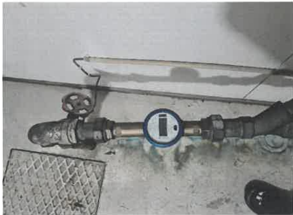
Kuva 31: Päävesimittari pohjakerroksessa.
