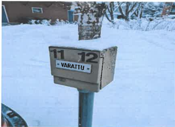
Kuva 38: Autonlämmityskotelo
