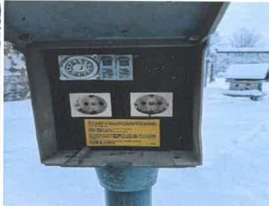
Kuva 39: Autonlämmityskotelon sisukset
