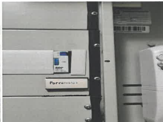
Kuva 52: Porrasvaloautomaatti.
