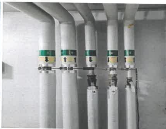
Kuva 48: Vesiputkien maadoitukset.
