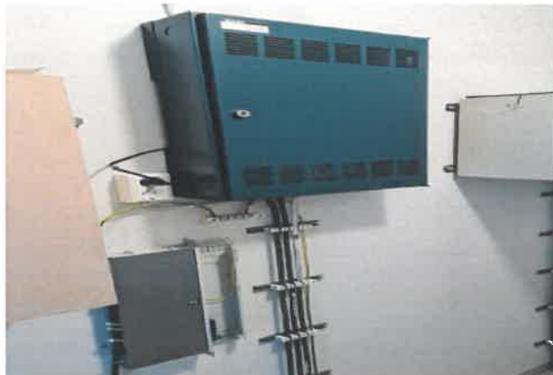
Kuva 58: Antennijärjestelmän päälaitteet.
