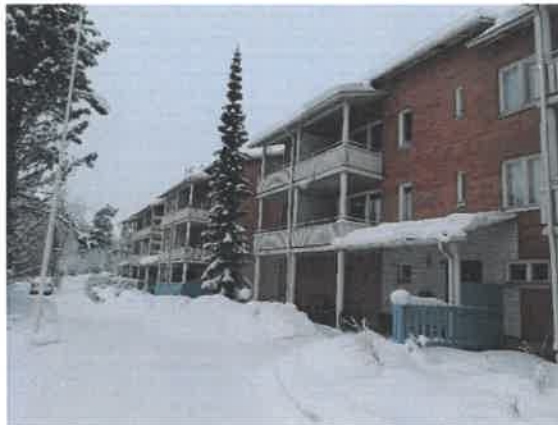
Kuva 1: Kivituhkapintojen kuntoa ei voitu arvioida maassa olevasta lumesta johtuen.
