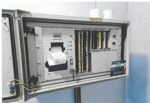
Kuva 60: SAVE järjestelmän pääyksikkö.
