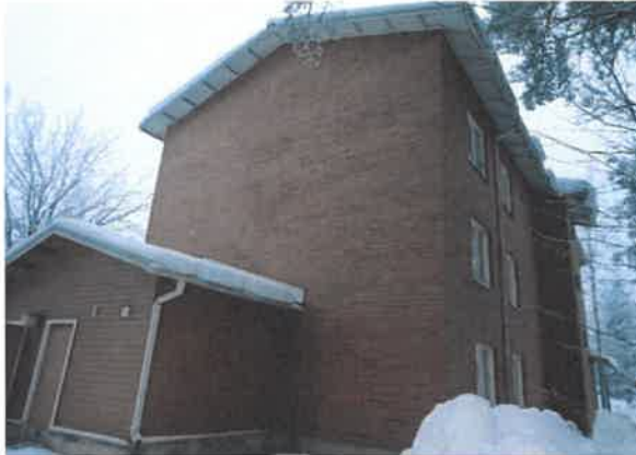
Kuva 5: Tiilimuurauksessa ei havaittu puutteita.
