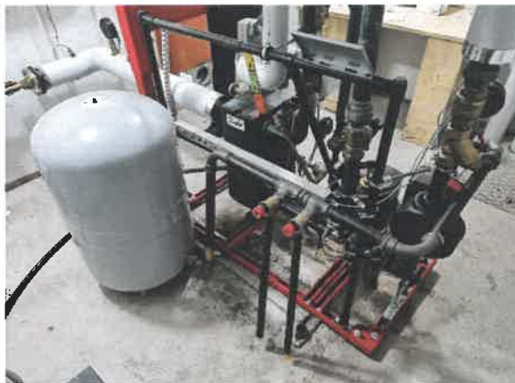
Kuva 27: Kaukolämmön alajakokeskus.
