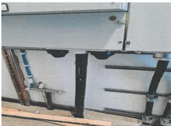
Kuva 44: Kiinteistön syöttöjohto.
