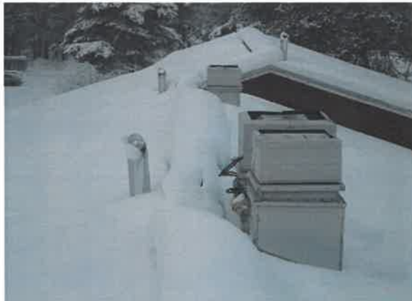
Kuva 35: Huippuimureita vesikatolla.
