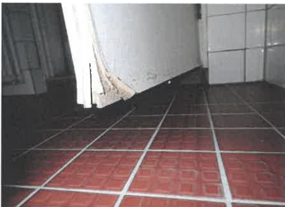
Kuva 21: Saunaosastolta ulos vilvoittelutuloon johtavien ovien kunto havaittiin heikoksi.
