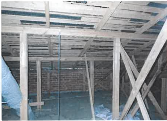
Kuva 13: Peltikatteen alapinnassa ei näkynyt vaurioita eikä jälkiä vesikatteen vuodoista ja yläpohjan tuuletuksessa ei havaittu puutteita.
