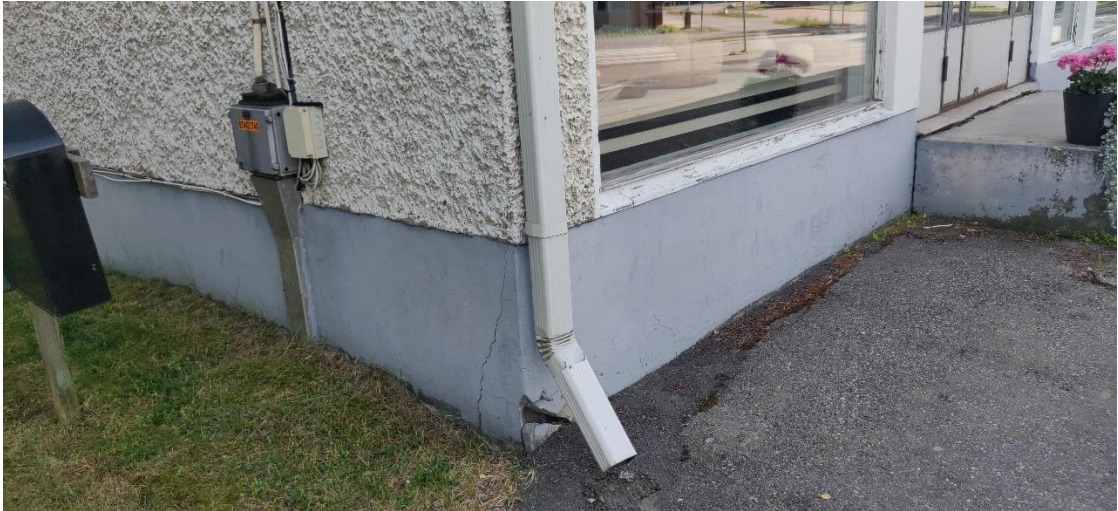
Kuva 2. Sadevedet on johdettu pihamaalle.
