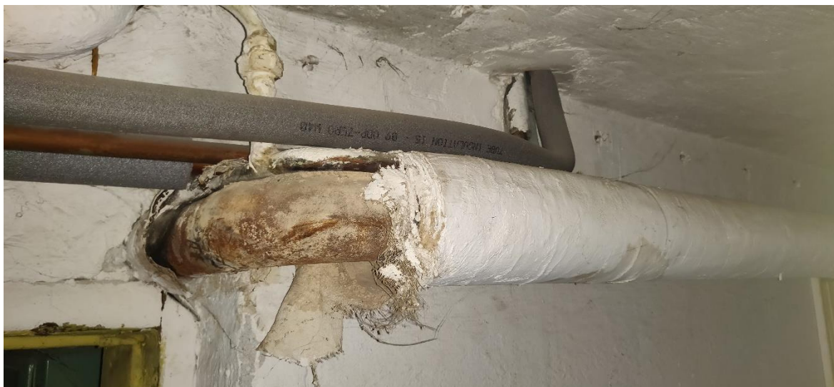
Kuva 8. Osa putkistojen korjaustoimenpiteistä on tehty paikkakorjauksina. Joukossa on myös alkuperäisiä järjestelmiä.
