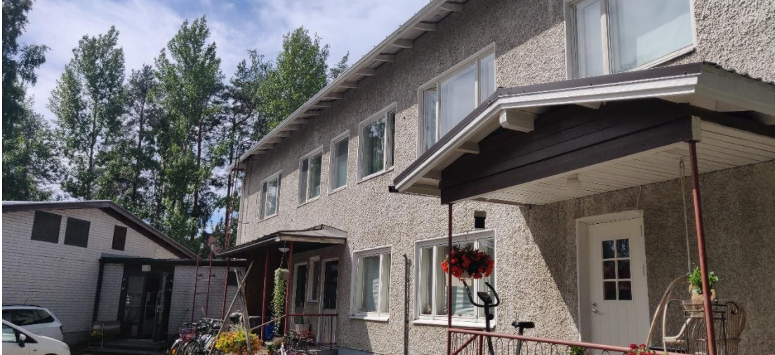
Kuva 5. Julkisivu takapihan puolella.
