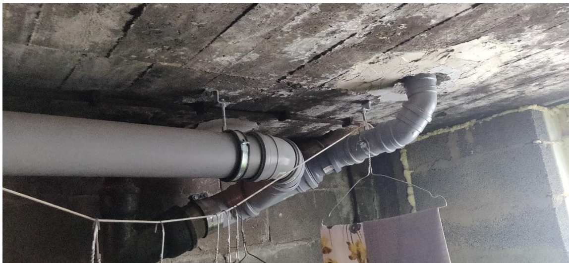
Kuva 7. Paikallisia korjauksia muutos- ja korjaustoimenpiteiden yhteydessä on toteutettu muoviviemärein.
