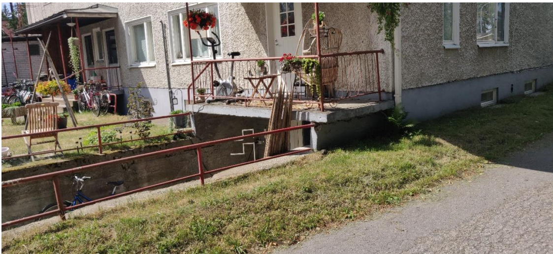
Kuva 3. Takapihan näkymä, kattovedet johdettu nurmikkoalueelle nurkassa.
