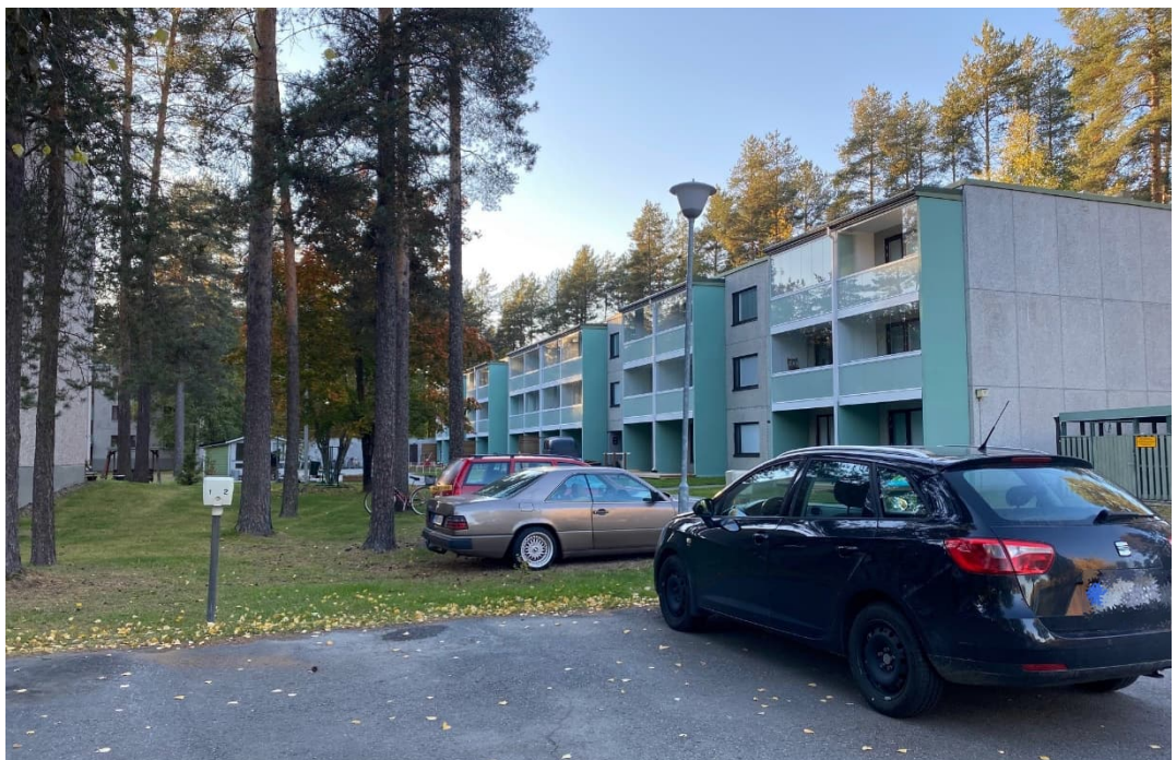
Kuva 3. Arkkitehti Osmo Niemen suunnitteleman Rantakylänkatu 17: kerrostalon parvekkeet lasitettiin vuonna 2020.
