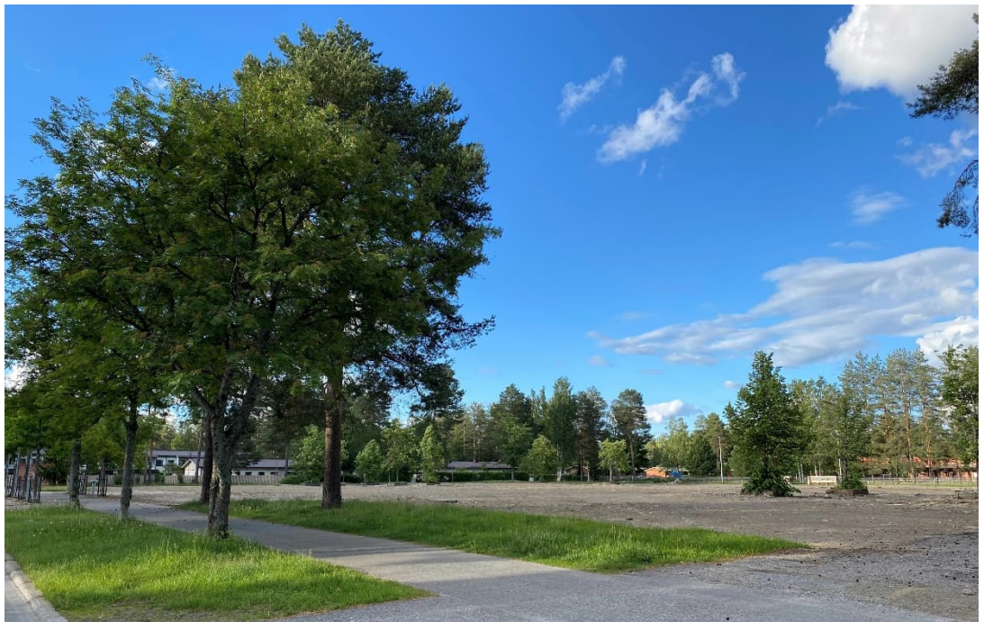
Kuva 2. Rantakylän koulun rakennus purettiin syksyllä 2020. Rantakylä-Utra-osayleiskaavassa tontille osoitetaan uusi käyttö asuinkerrostaloalueena.
