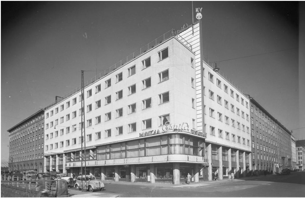
Kuva: Hytösen ja Paatelan Kauppakorkeakoulun ylioppilaskunnan talo (1941) Pohjoisella Rautatiekadulla Etu-Töölössä on käynyt läpi lukuisia muutoksia: tuoreimmassa ("Kulma21") rakennus puretaan rungolle ja toimitilakäyttöön valmistuen vuoteen 2023 mennessä. 9 Viljo Pietinen 1946, Museovirasto.
