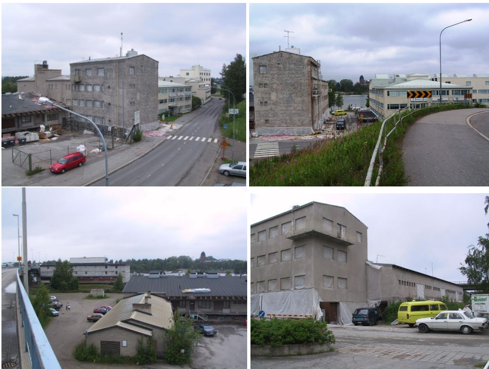
Kuvat: Inventointikuvat 2002. Arkistokuvia julkisivuremontista 2002. Alavassemalla purettu korjaamosiipi. Joensuun kaupunki.
