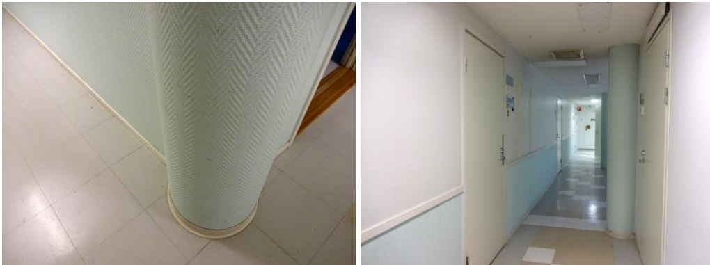
Kuvat: Pilareita on verhottu osaksi kevyitä väliseinärakenteita.
