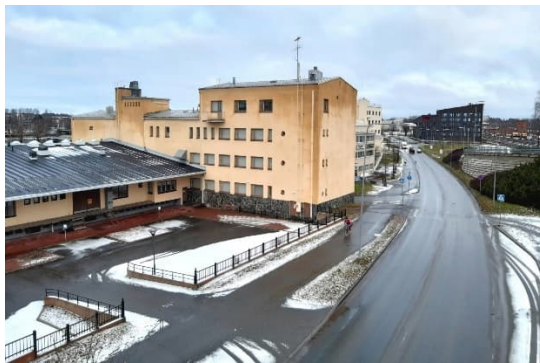
Kuva 2: Muutosalue Suvantosillalta. ©Joensuun kaupunki 2021.
