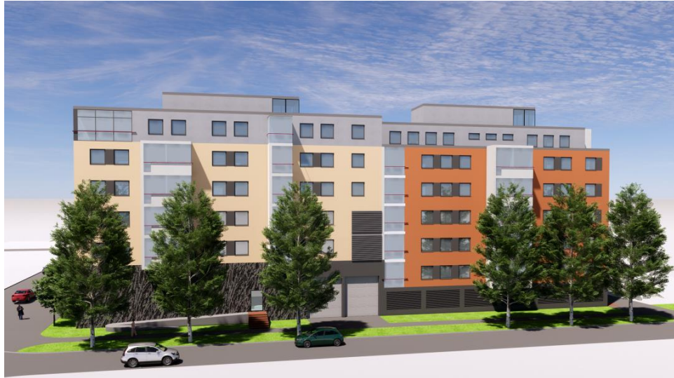
Havainnekuva luoteesta (PKO, Suunnittelutoimisto Pauli Nuutinen Ky). Kuusi- ja seitsemänkerroksisen rakennuksen harjakorkeus on sama, johtuen Suvantokadun kaupantilojen korkeammasta kerroskorkeudesta ja kellaripysäköinnistä.
