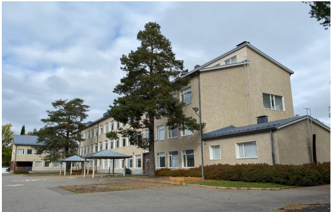
Kuva 2: Juhanalan koulu koulupihalta katsoen. Koulurakennus on ollut tyhjiään jo vuosia, eikä kaupungilla ole rakennukselle enää käyttöä.
