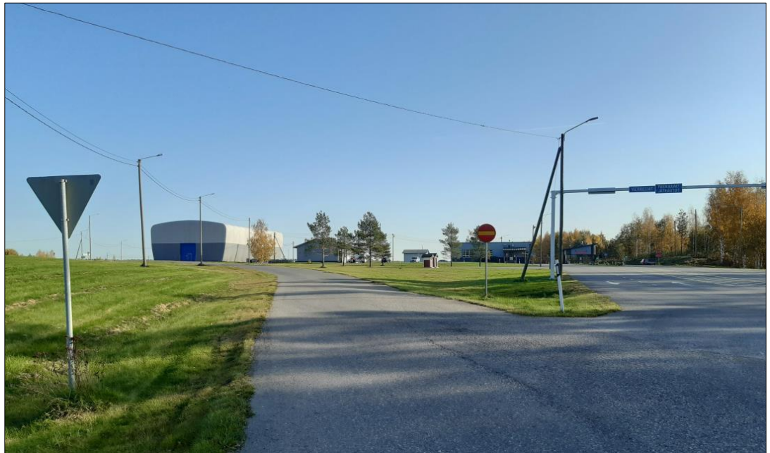
Kontiosuon jäteaseman sisääntulotie oikealla ja poistumistie keskellä.
