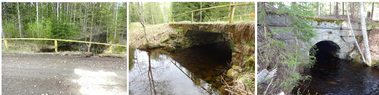
Siltarakenteita. Kissapuro, Hepopuro.
