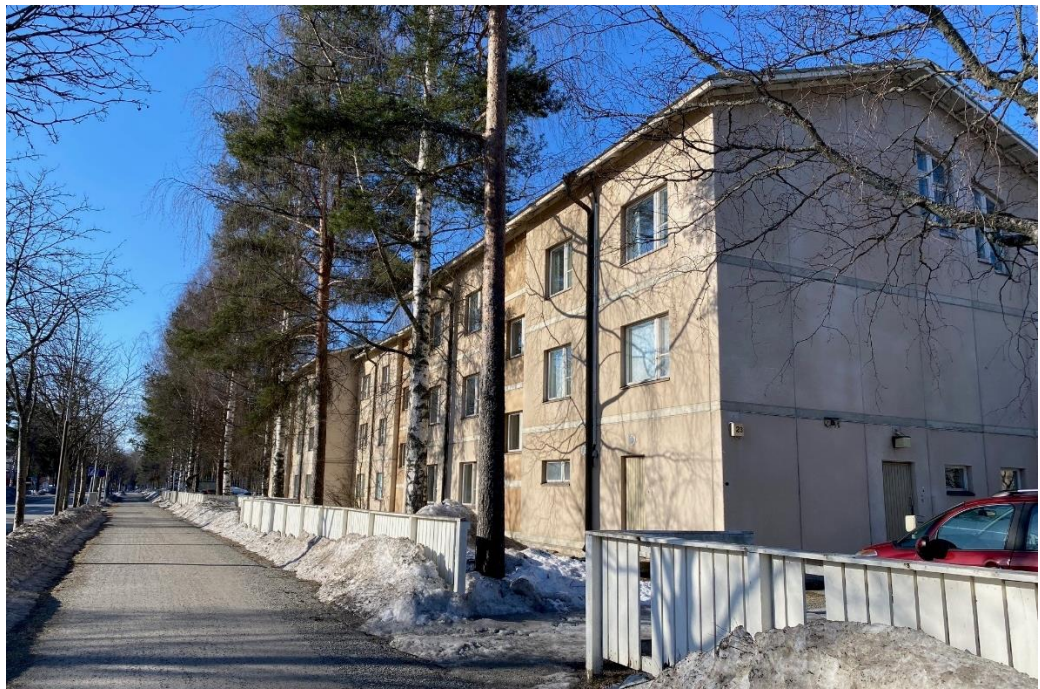
Kuva 2: Latolankadun katunäkymää eteläsuuntaan.
