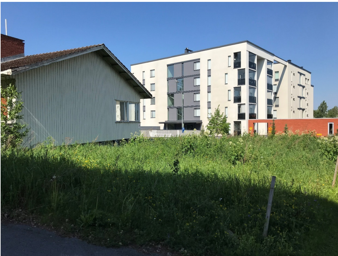
Rakennuksen pohjoispääty ja hoitamaton piha-alue
