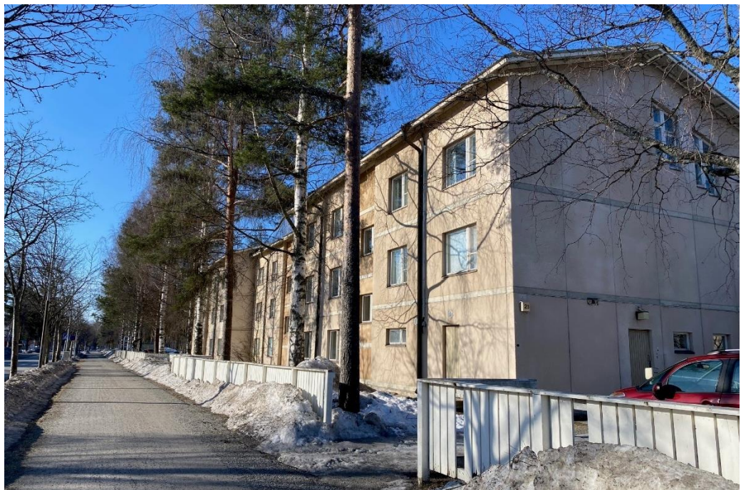
Kuva 2: Latolankadun katunäkymää eteläsuuntaan.
