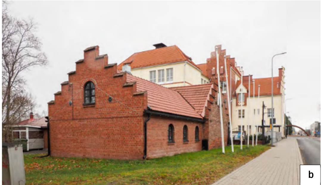
Kuva 3. a Entinen tyttökoulun päärakennus kanavapuistolta katsottuna (kaavoitus, 2024) ja talousrakennus Rantakadulta katsottuna (Ark-Byroo 2024).
