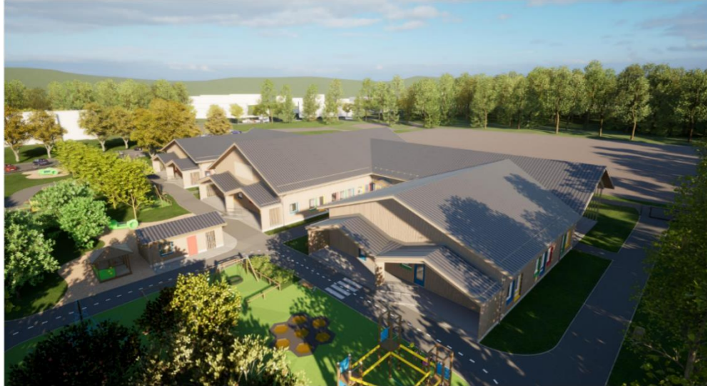
Kuva 12. Tilakeskuksen esittämä havainnekuva Noljakan tulevasta päiväkodistä. Reijolan hankesuunnitelma vastaa pitkälti Noljakan suunnitelmaa, jonka vuoksi se antaa hyvän kuvan siitä, millainen rakennus alueelle on suunnilleen rakentumassa.
