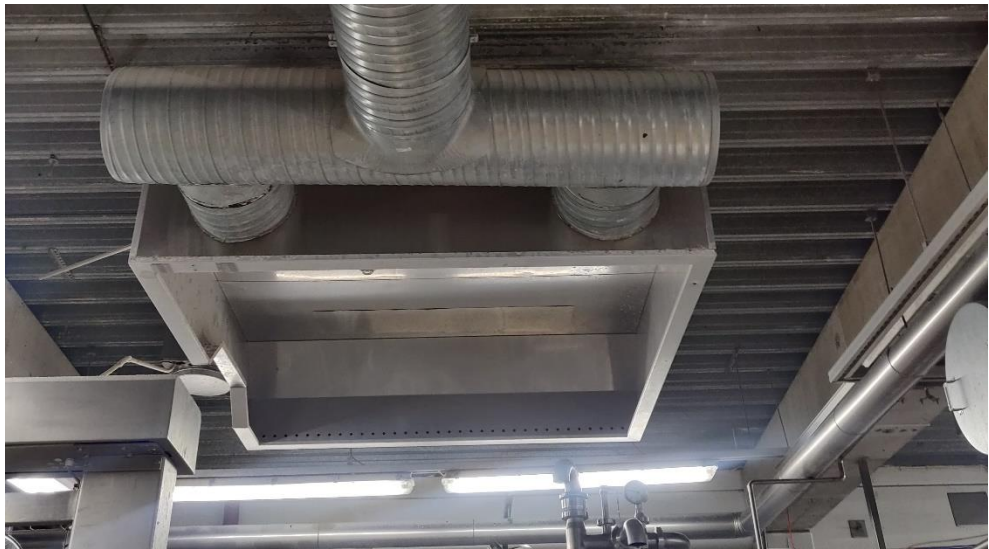
Kuva 23/LVI Poistoilmahuuvut ovat pääsääntöisesti hyvässä kunnossa
