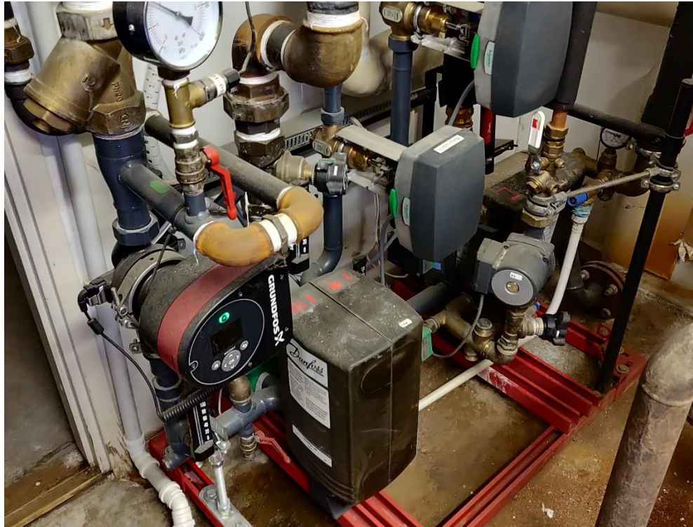
Kuva 12/LVI Käyttöveden lämmönvaihtimet on pääosin uusittu
