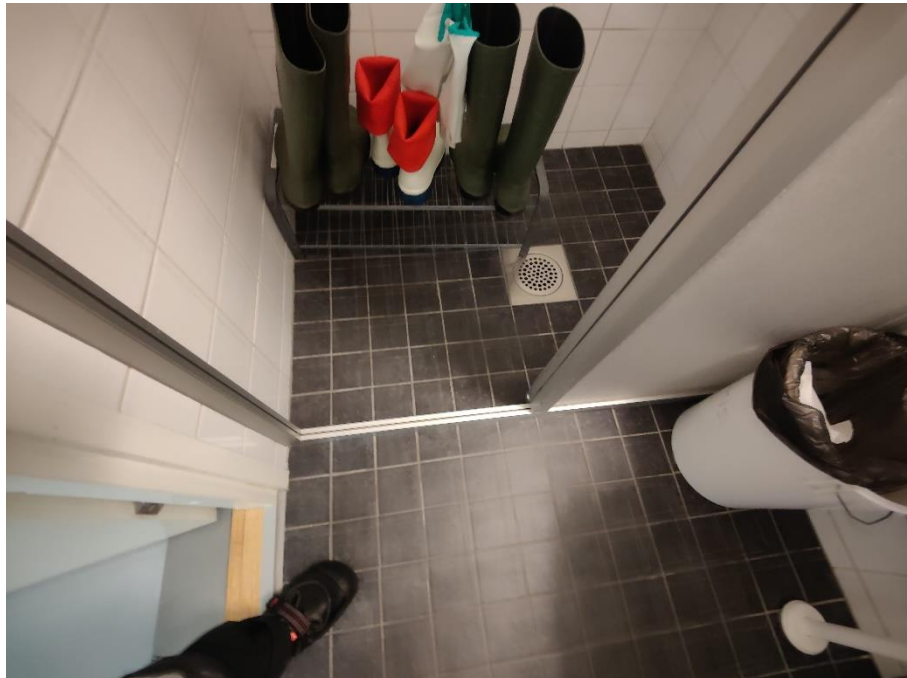
Kuva 40/RAK. Yleiskuvaa märkätilojen pinnoista.
