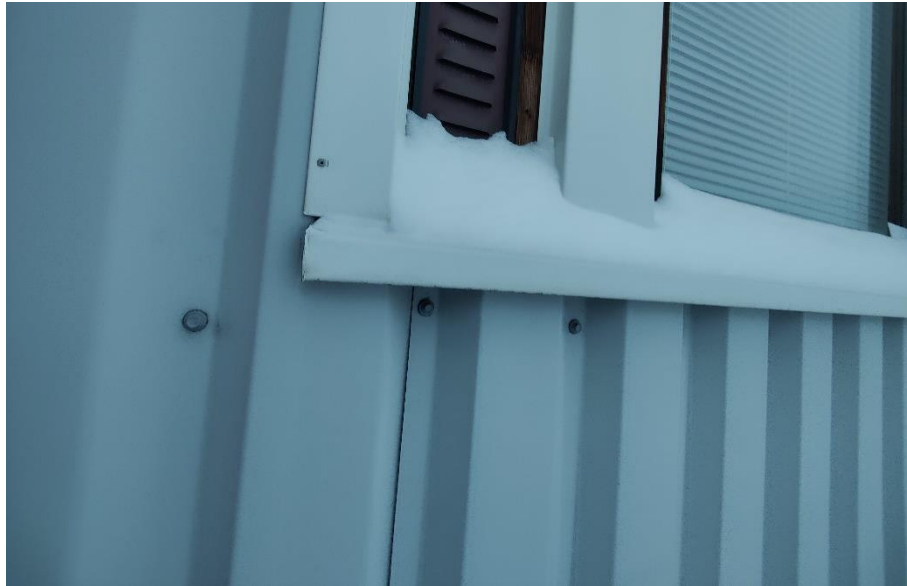
Kuva 5/RAK. Yleiskuva julkisivupinnoitteesta.
