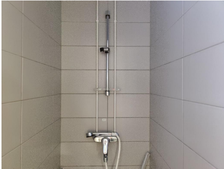
Kuva 17/RAK. Seinäpintoja pesuhuoneessa.
