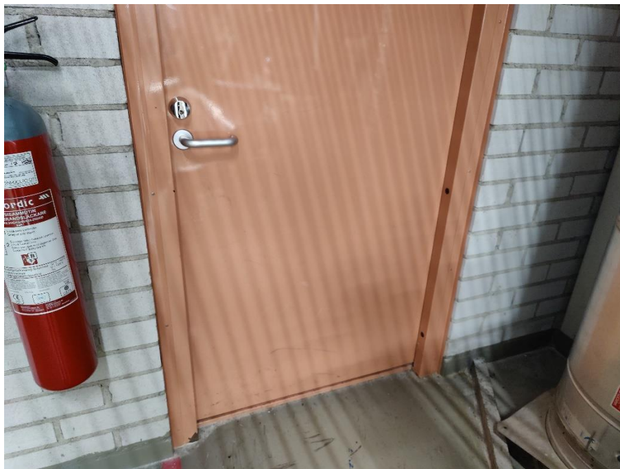
Kuva 37/RAK. Yleiskuvaa tuotantotilojen metalliovesta.
