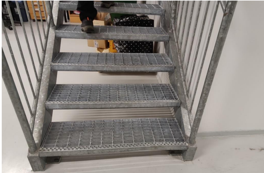
Kuva 4/RAK. Rakennuksen teräsportaat.
