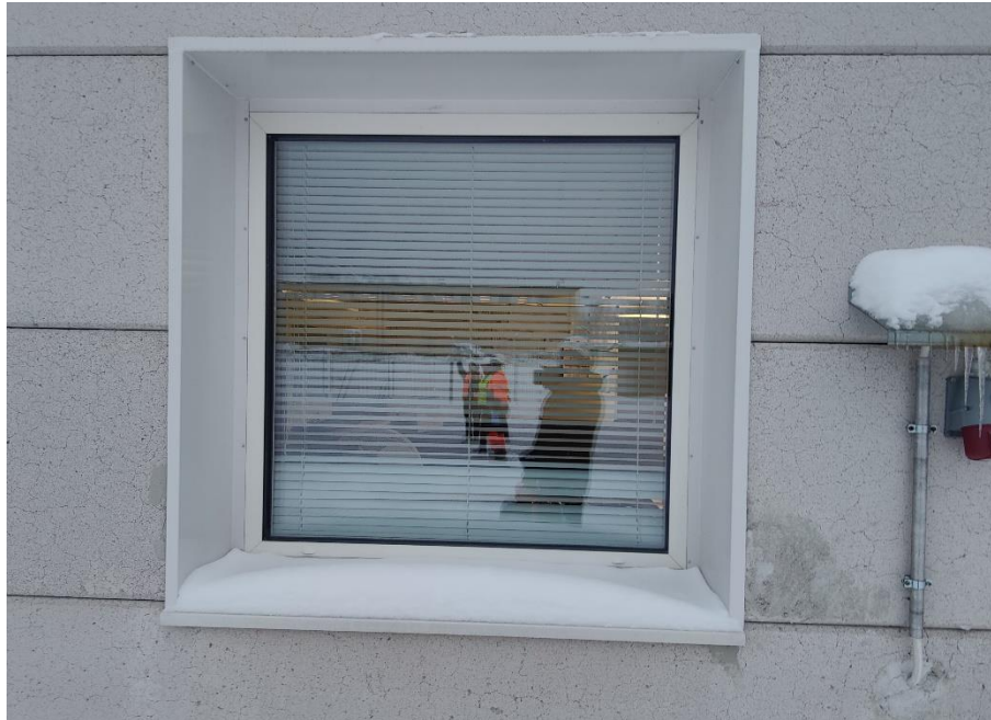
Kuva 33/RAK. Yleiskuvaa toimisto-osan (A-osa) ikkunoista.
