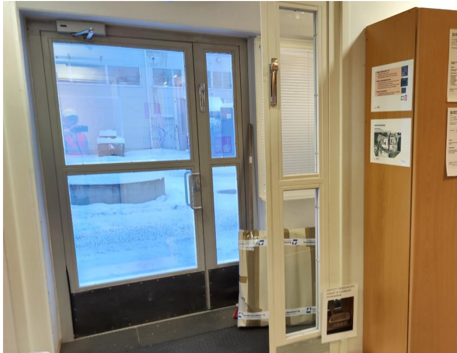
Kuva 34/RAK. Yleiskuva toimisto-osan ulko-ovesta.
