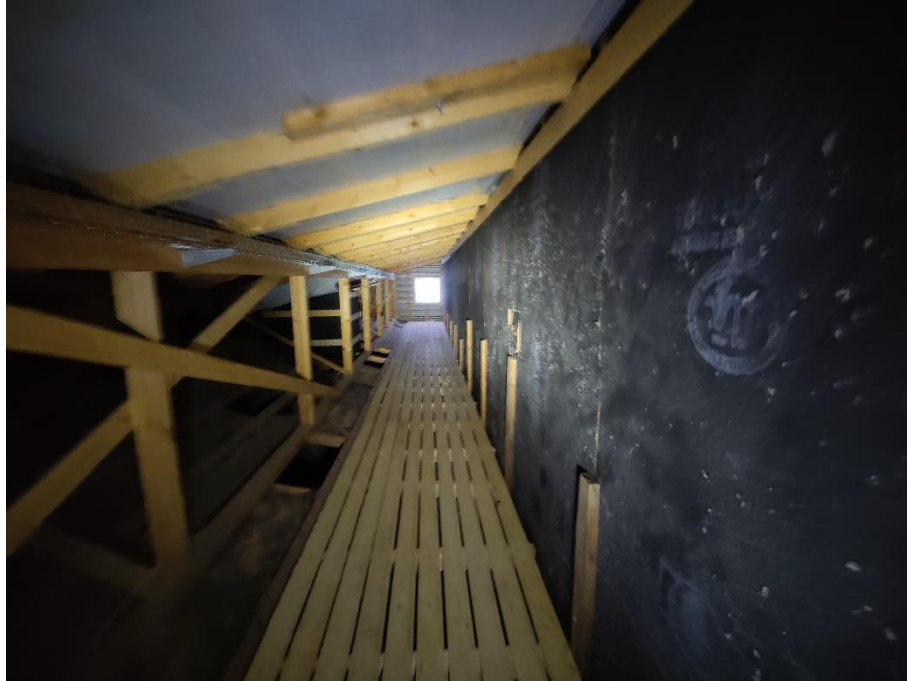
Kuva 3/RAK. Yleiskuvaa varasto-osan yläpohjatilasta.
