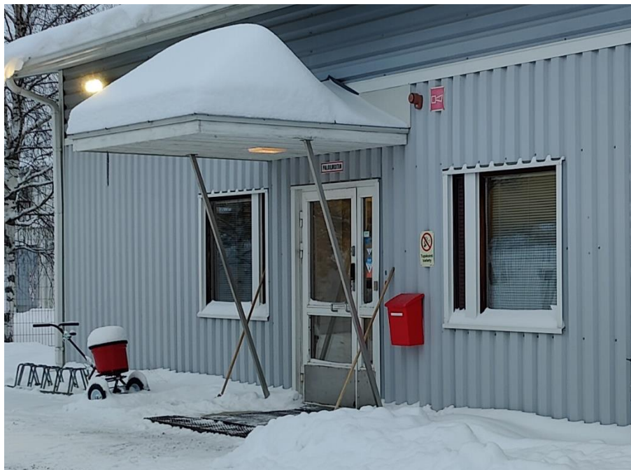
Kuva 7/RAK Pääsisäänkäynnin ulko-ovi.
