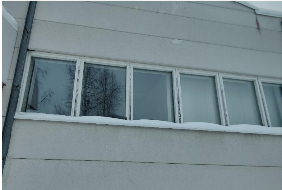
Kuva 32/RAK. Ikkunat uudella keitto-osalla.
