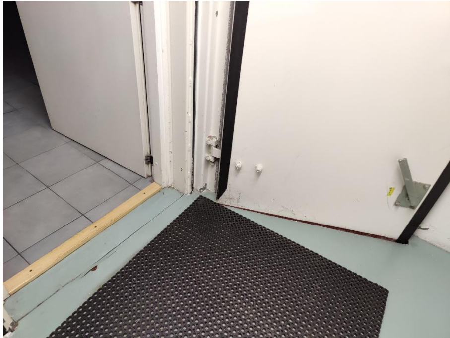
Kuva 21/RAK. Väestönsuojan sisäänkäynti.
