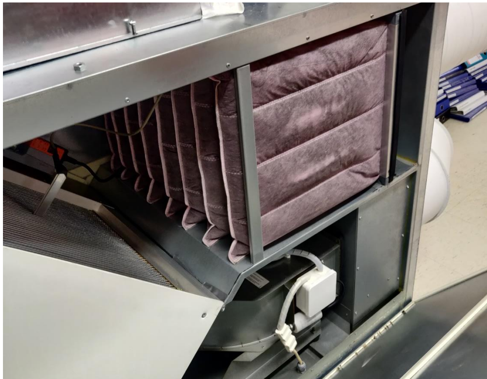
Kuva 2/LVI Yläkerran tiloja palveleva IV-kone tarkastettiin sisäpuolelta. Puhtaudessa ei havaittu merkittäviä puutteita mutta suodattimet olivat likaiset
