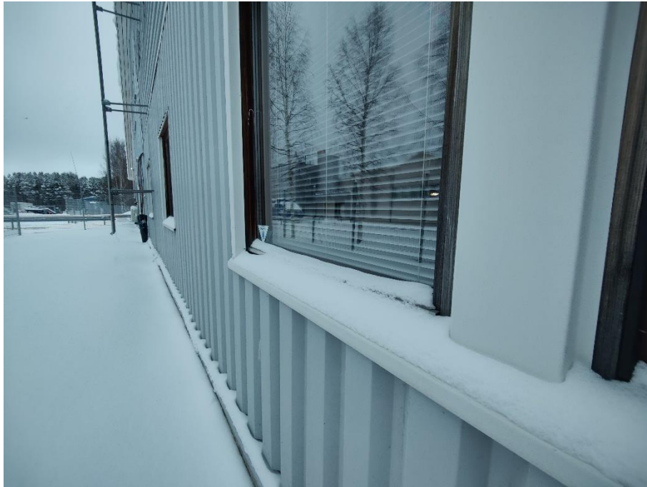
Kuva 6/RAK. Yleiskuva rakennuksen ikkunoista.
