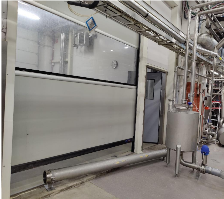
Kuva 38/RAK. Tuotantotilojen nosto-ovi sekä puuovi.
