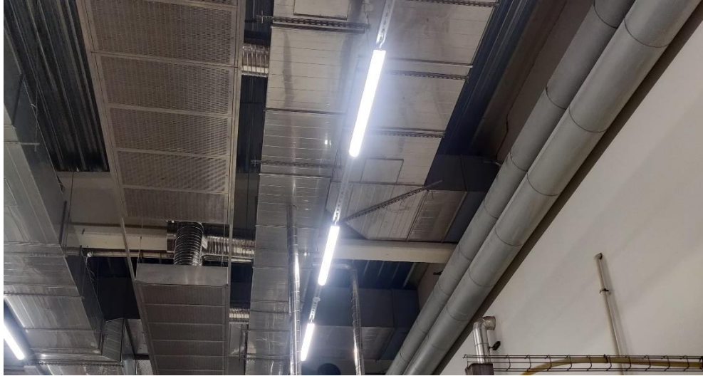
Kuva 20/LVI Vesikaton peruskorjauksen yhteydessä on osittain tuotantotiloja palvelevista kanavistoista uusittu RST-kanavilla
