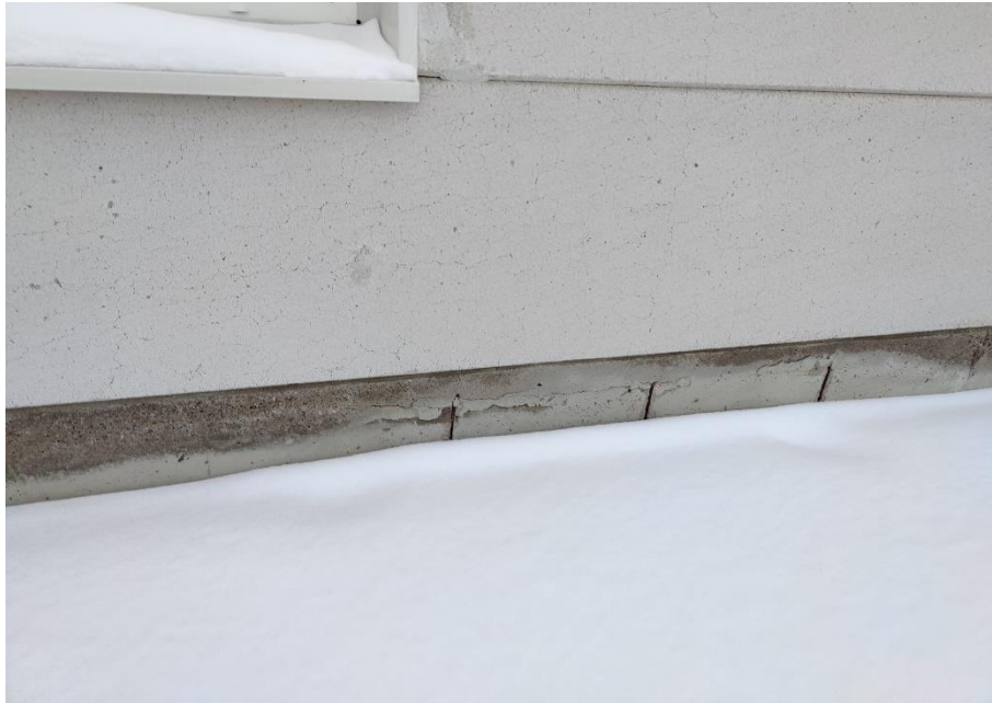
Kuva 20/RAK. Yleiskuvaa perusmuurin kunnosta.
