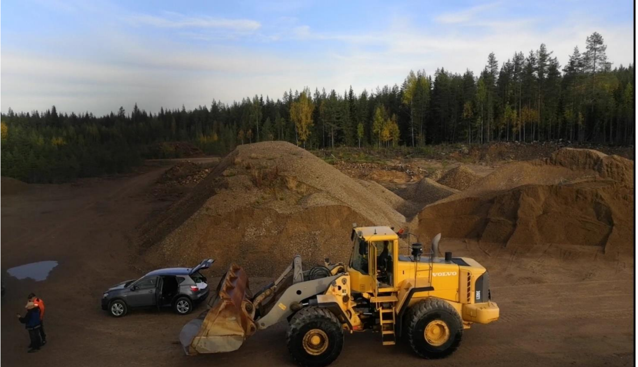
Kuva 4. Otettu kohti Tervavaarantietä (Pohjoiseen)
