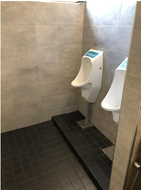
Kuva 46 Asiakas- WC uusittu
