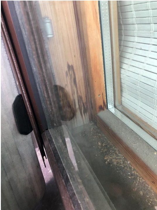
Kuva 24 Ikkunan vuotojälkiä
