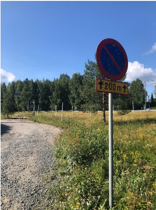
Kuva 8 Liikennemerkki huonossa kunnossa
