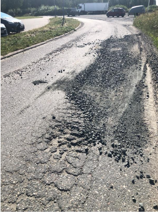
Kuva 1 Asfalttia korjattu soralla
