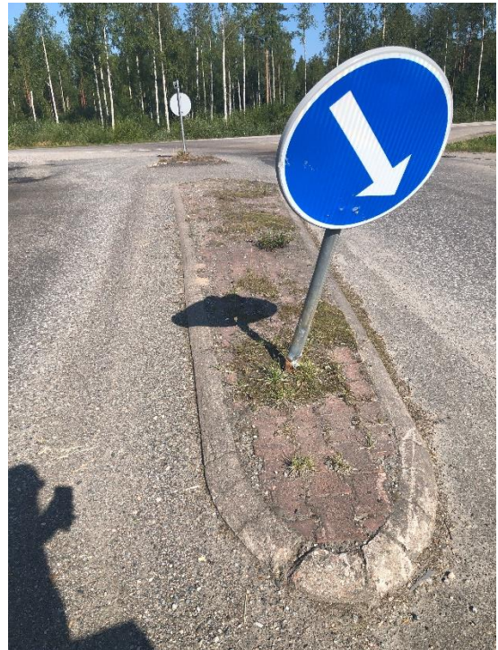
Kuva 9 Liikennemerkki vinossa, kiveyksen uusiminen
