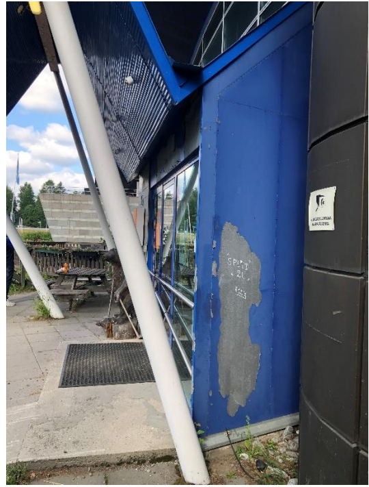
Kuva 31 Pääoven katoksen huoltomaalaus
