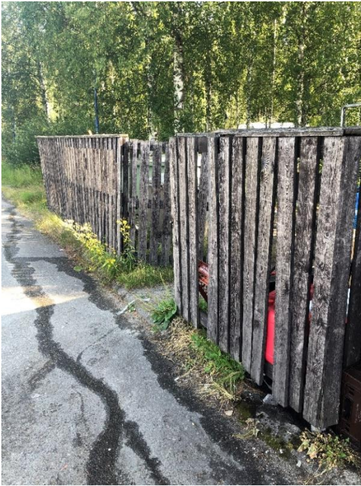
Kuva 12 Aidan korjaus ja huoltomaalaus
