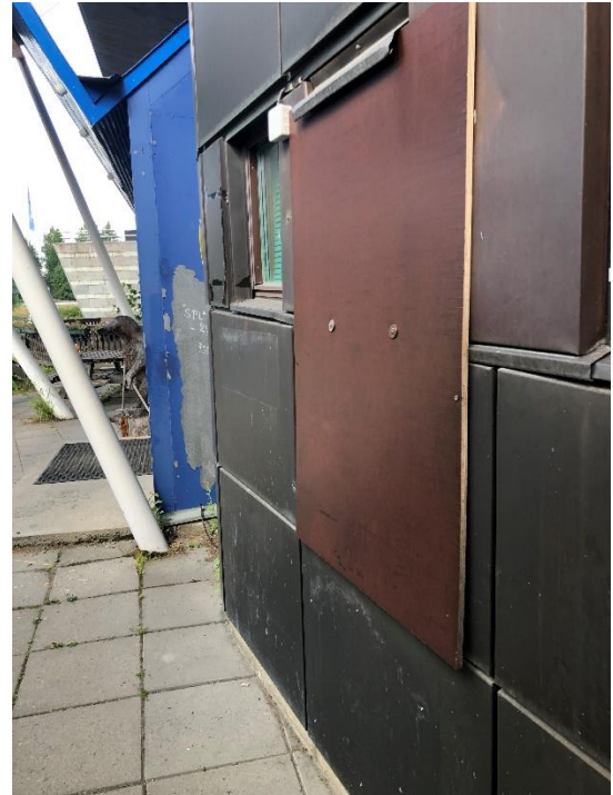
Kuva 19 Etusivua peitetty vanerilla
