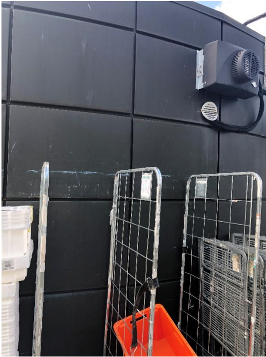
Kuva 20 Peltikasetin vaurioita
