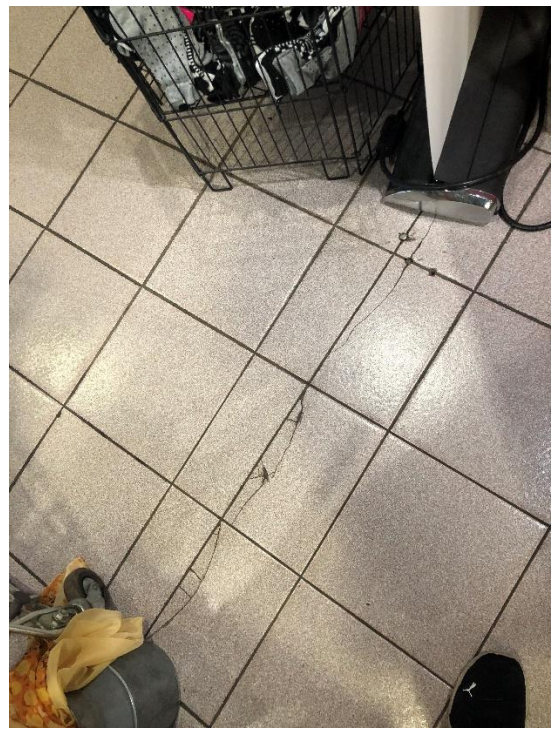
Kuva 39 Laatoitus halkeillut
