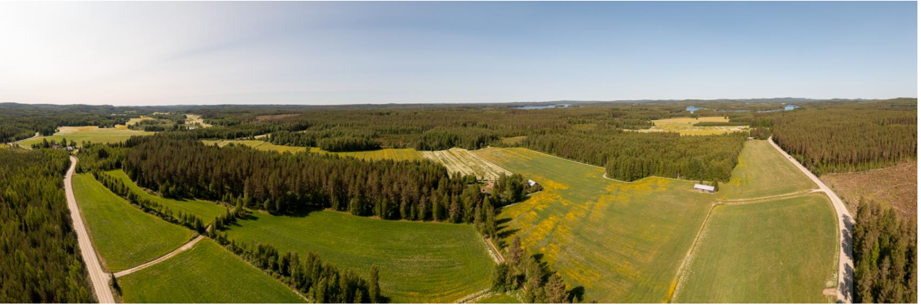
Kuva 48. Pohjoisosa, länteen, 120 m korkeus.
