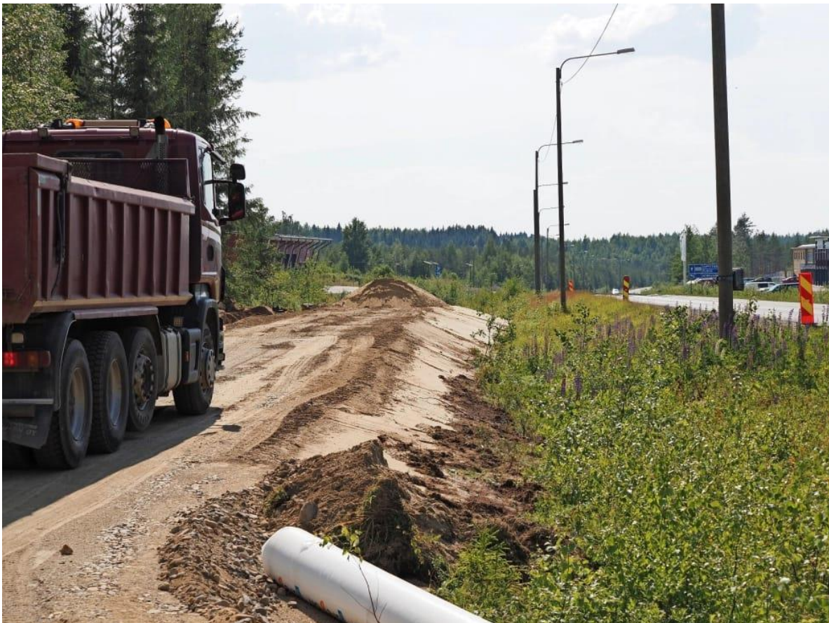
Puhostien kevyenliikenteenväylä valmistui syksyllä 2023.
