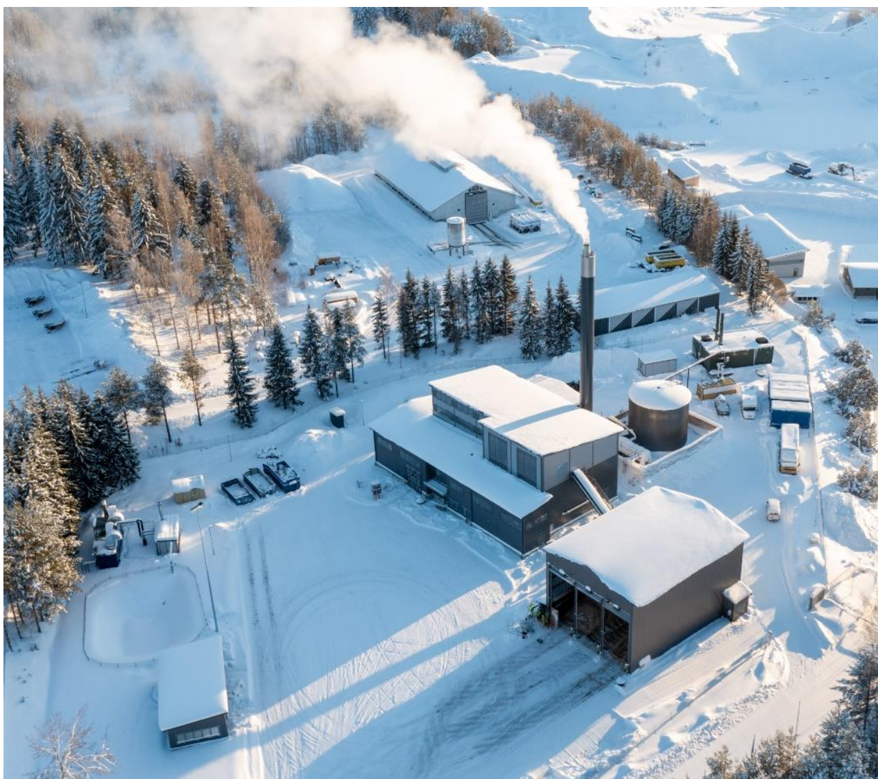
Kiteen Lämmön uusi Arppen lämpölaitos.
