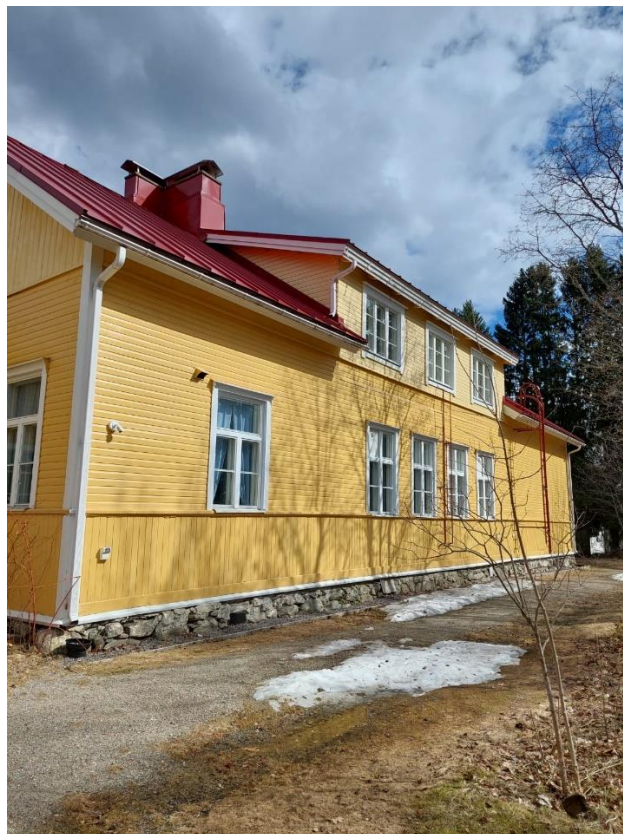
Sovintolan julkisivu sai kesällä 2023 uuden maalipinnan.
