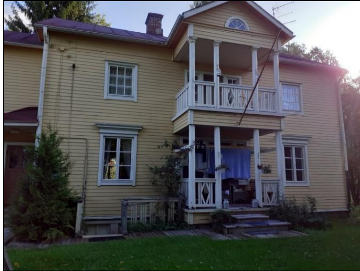
Kuva 6. Termän talossa on koristeellinen kuisti ja terassi.
