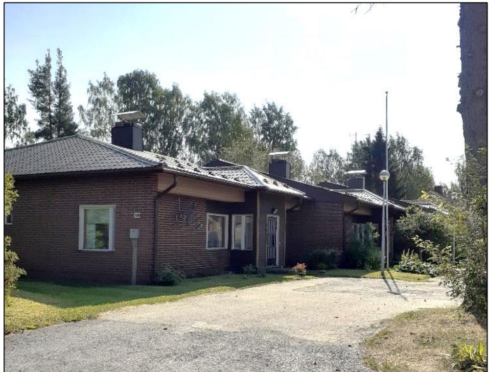
Kuva 7. Koulukatu 19 sijaitsevan rivitalon julkisivua.
