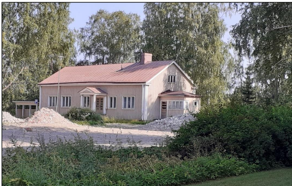
Kuva 5. Kauppalantalon oikeassa päädyssä on kuistimainen uloke.
