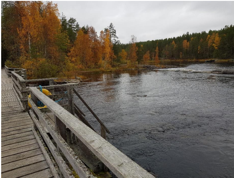
Kuva 9. Puinen kulkusilta patorakennelman päällä, kuva saaren suuntaan.
