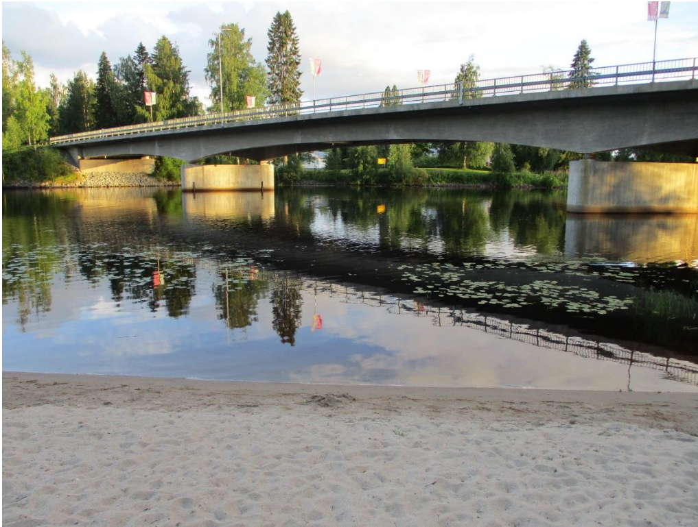
Kuva 2. Lieksanjoen silta kuvattuna pohjoisen suunnasta. Etualalla näkyy pieni hiekkaranta puistossa hotellin edustalla.
