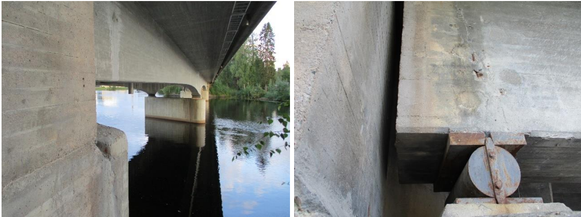
Kuvat 13 ja 14. Lieksanjoen silta ja kapea rako sillan päässä.
