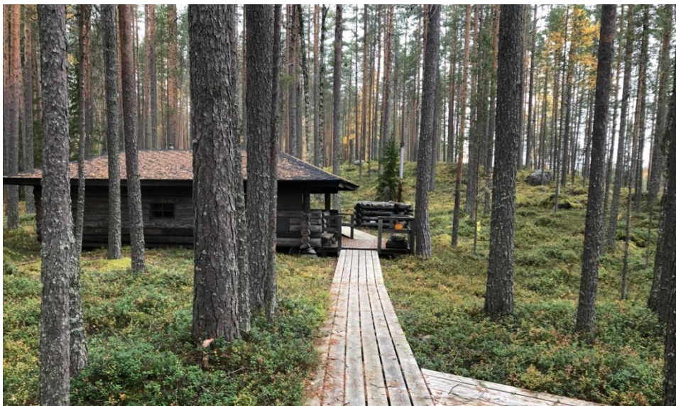
Kuva 6. Rakennuskantaa Kattilakosken alueella.
