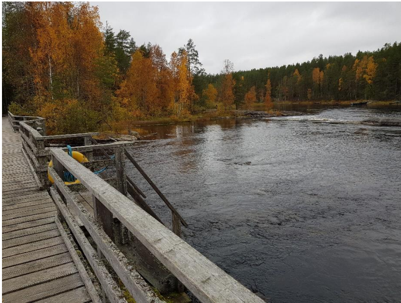
Kuva 9. Puinen kulkusilta patorakennelman päällä, kuva saaren suuntaan.
