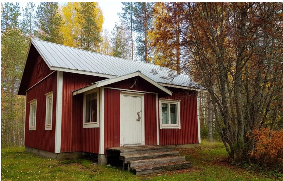
Kuva 7. Siikajärven itäosan rakennuskantaa, Paasolan tila.
