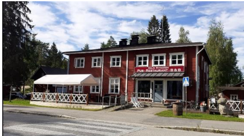
Kuva 26. Ylä-Kolintie 1a:n ns. Kolin Rynnäsen liikerakennus, jossa harjoitetaan ravintola- ja majoitustoimintaa. II-kerroksinen päärakennus on rakennettu hirsistä ja julkisivu on värityksenä punamulta. Se on rakennettu vuonna 1939. Rakennus oli alun perin "monitoimitalo" sisältäen kaupan, majoitustiloja sekä asunnon Rynnäsille.
