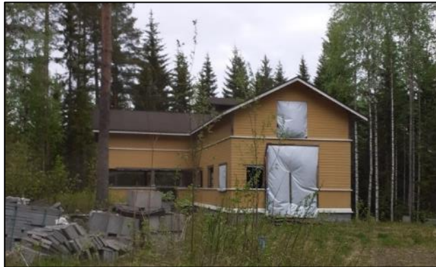
Kuva 17. Mäkirinteentie 4:ssä sijaitsee keskeneräinen 1,5-kerroksien julkisivultaan keltainen puinen pientalo.
