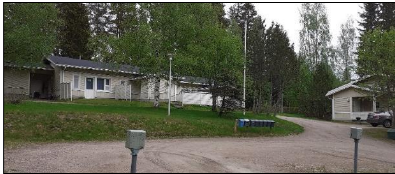
Kuva 16. Martikkalantie 3:n rinteessä sijaitsee rivitaloyhtiö kaksine taloineen vaalealla puujulkisivulla.
