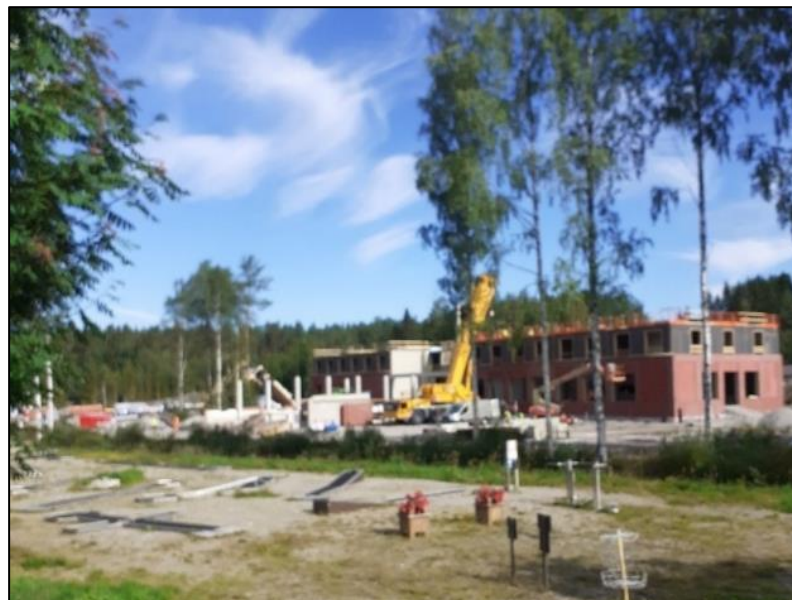
Kuva 24. Kolintien varrelle PKO:n Sale kaupparakennuksen pohjoispuolelle on rakenteilla Hotelli. Kuvassa etualalla on mm. minigolfrata, joka ei kuulu asemakaava-alueeseen.
