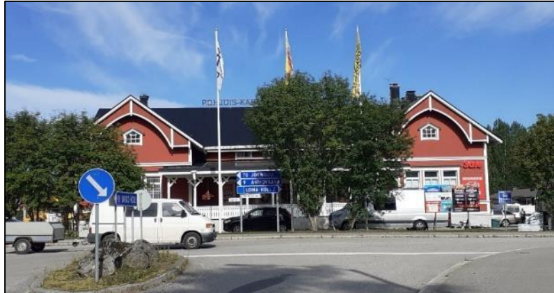
Kuva 25. Kolintie 94a:ssa on PKO:n päivittäistavarakauppa Sale. Se on näkyvällä paikalla kylässä, ja siinä on uusrenessanssia ja jugendtyylisiä koristekuviota puujulkisivussa. Rakennus on II-kerroksinen.
