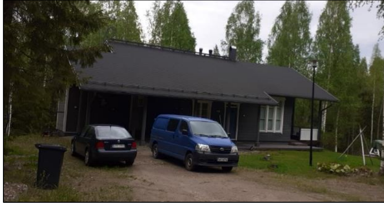
Kuva 19. Mäkrinteentie 8:ssa sijaitsee uudehko harmaa hirsitalo.
