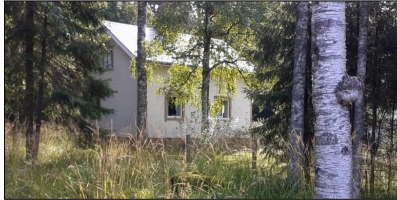
Kuva 31. Ylä-Kolintie 6 on 1,5-kerroksinen valkoinen lautajulkisivuinen pientalorakennus.
