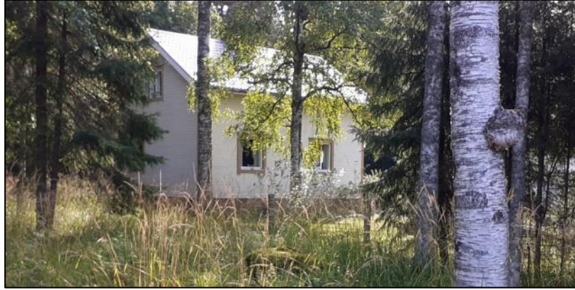
Kuva 31. Ylä-Kolintie 6 on 1,5-kerroksinen valkoinen lautajulkisivuinen pientalorakennus.
