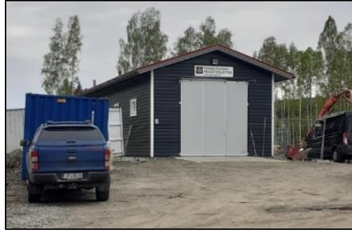
Kuva 15. Martikkalantie 2 sijainnut uudehko Kolin palokunnan hallirakennus on jo siirretty Merilänrannantien varteen.
