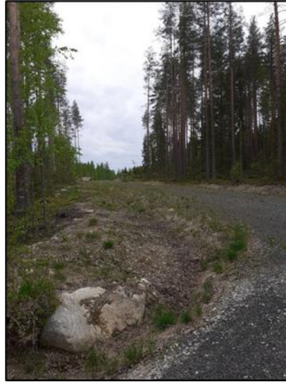
Kuva 9. Näkymä jo rakennetulle kaavatielle sen pohjoispäästä nykyisen Lahnarinteen yksityistien risteyksestä.
