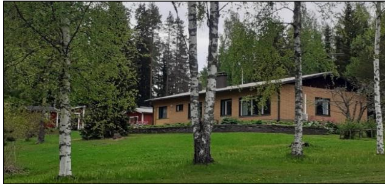
Kuva 12. Martikkalantie 1 talo on kellertävä 1-kerroksinen tiilitalo.
