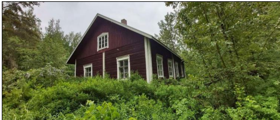
Kuva 36. Merilänrannantie 6:ssa on Tiensuun tilan punaisella päärakennuksella. Rakennus on vaurioitunut.
