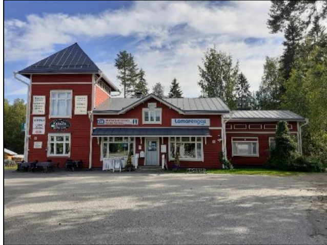
Kuva 28. Ylä-Kolintie 2a on entinen Kolin kyläkauppa, jossa toimi 1960-1990-luvuilla T-kauppa. Nykyään rakennuksessa on mm. matkailuneuvontaa, puoti ja kahvila. Rakennuksella on punainen lautajulkisivu. Rakennus on osin II-kerroksinen.
