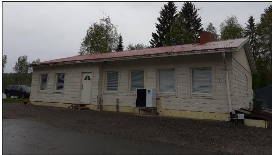
Kuva 13. Merilänrannantie 2 on entinen Juuan Osuuskassan ja sittemmin Juuan Osuuspankin Kolin konttori, joka on kunnostettu asunnoksi valkealla puujulkisivulla.
