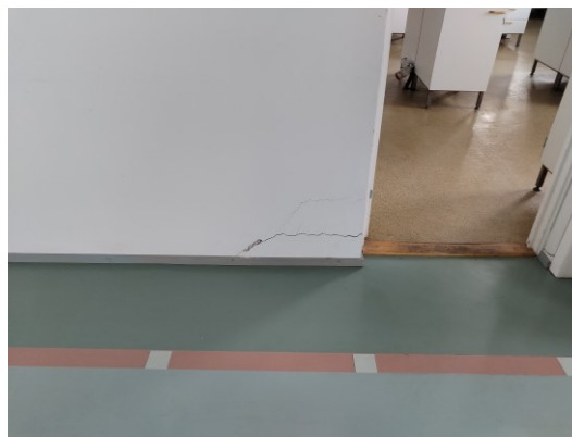
Rakennuksen perustukset ovat liikkuneet ja halkovat seiniä ym. muutamain paikoin.
