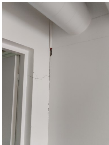
Rakennuksen perustukset ovat liikkuneet ja halkovat seiniä ym. muutamain paikoin.
