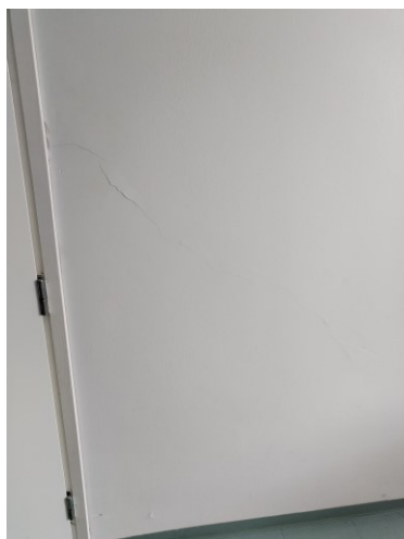
Rakennuksen perustukset ovat liikkuneet ja halkovat seiniä ym. muutamain paikoin.
