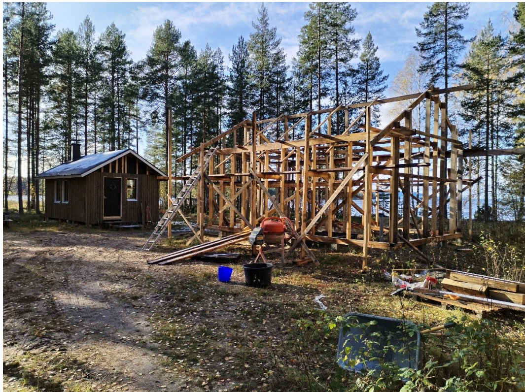
Kuva 6. Rakenteilla oleva lomatontti korttelissa 14.
