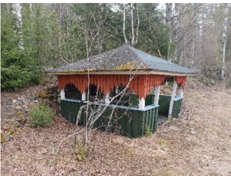
Kuva 16. Grillikatos. Rakentamisen ajankohta ei ollut tiedossa. (Kuva: Lieksan kaupunki)
