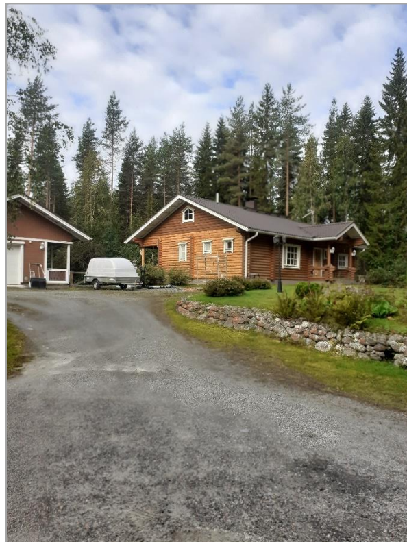
Kuva 17. Loimutie 12:ssa on hirsitalo, joka on valmistunut vuonna 1999.
