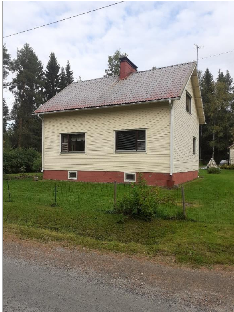
Kuva 18. Sahatie 2 rintamiestyyppinen asuinrakennus vaalealla laudoituksella, ja se on valmistunut vuonna 1952. Rakennus on osa kaupunki- ja kyläkuvallisesti tärkeää aluetta (sk).
