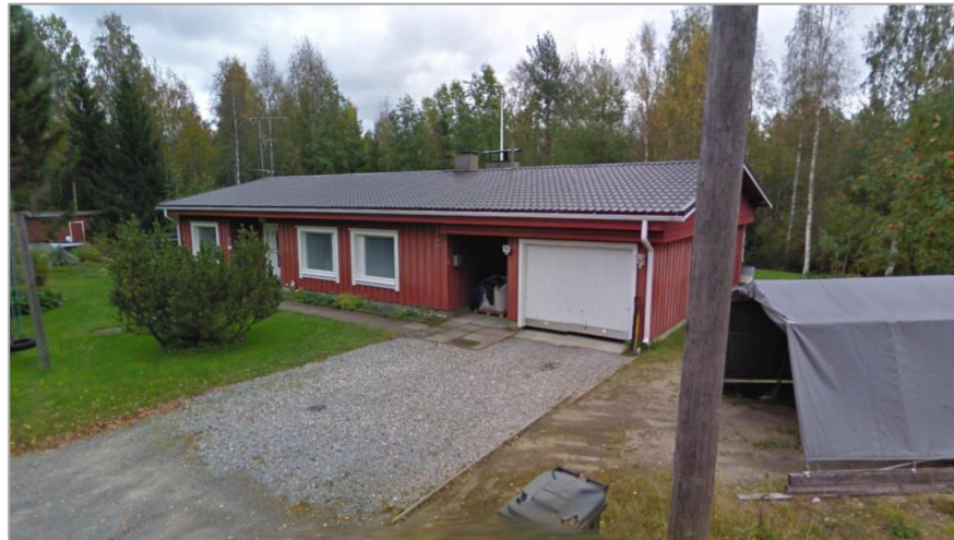
Kuva 15. Punainen puuverhoiltu asuinrakennus Sepäntie 19, mikä on valmistunut vuonna 1981.
