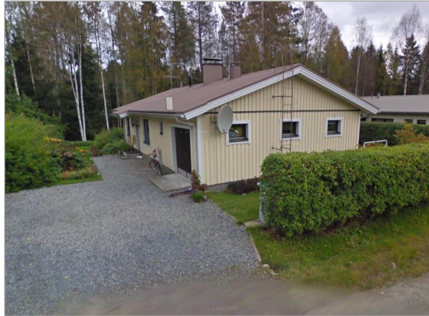
Kuva 12. Vaalea 1-kerroksinen asuinrakennus Savutie 5, mikä on valmistunut vuonna 1988.
