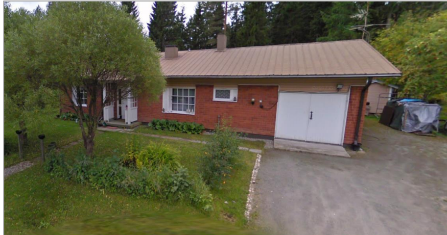
Kuva 14. Punainen tiili- ja lautaverhoiltu asuinrakennus Liekkitie 2:ssa, mikä on valmistunut vuonna 1982.
