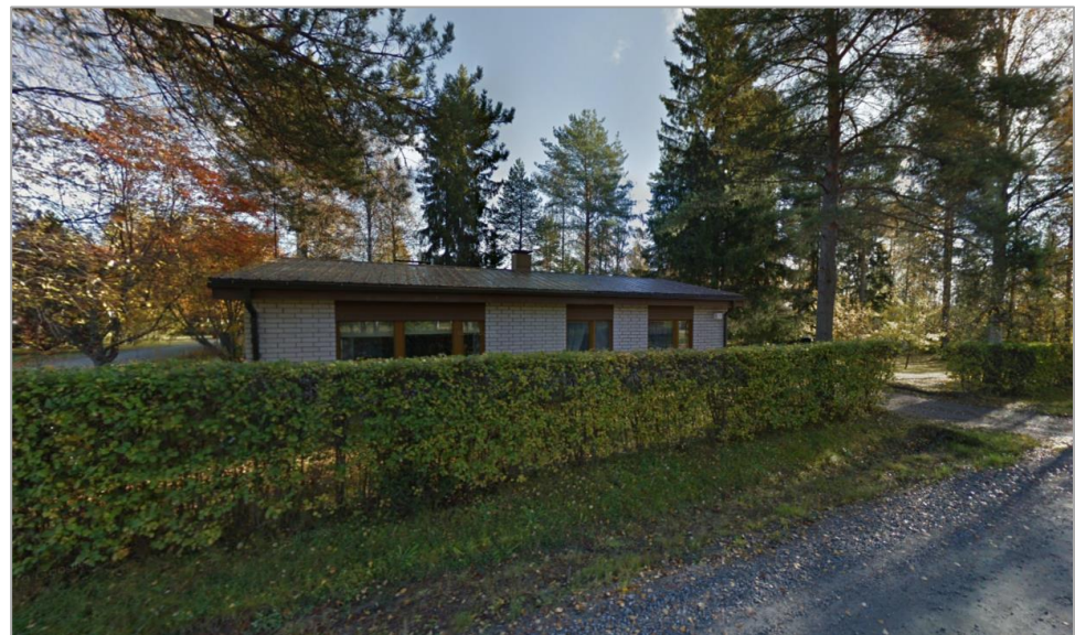
Kuva 6. Riihivaarantien 1 1-kerroksinen vuonna 1976 rakennettu rakennus.
