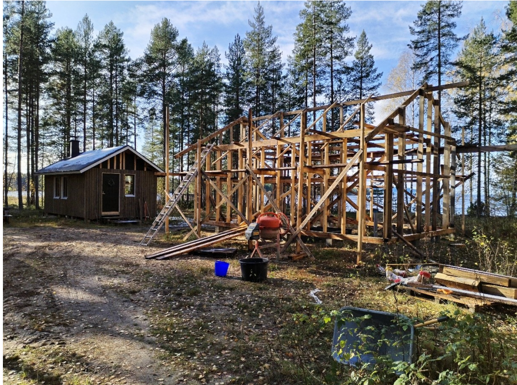
Kuva 7. Rakenteilla oleva lomatontti korttelissa 14.
