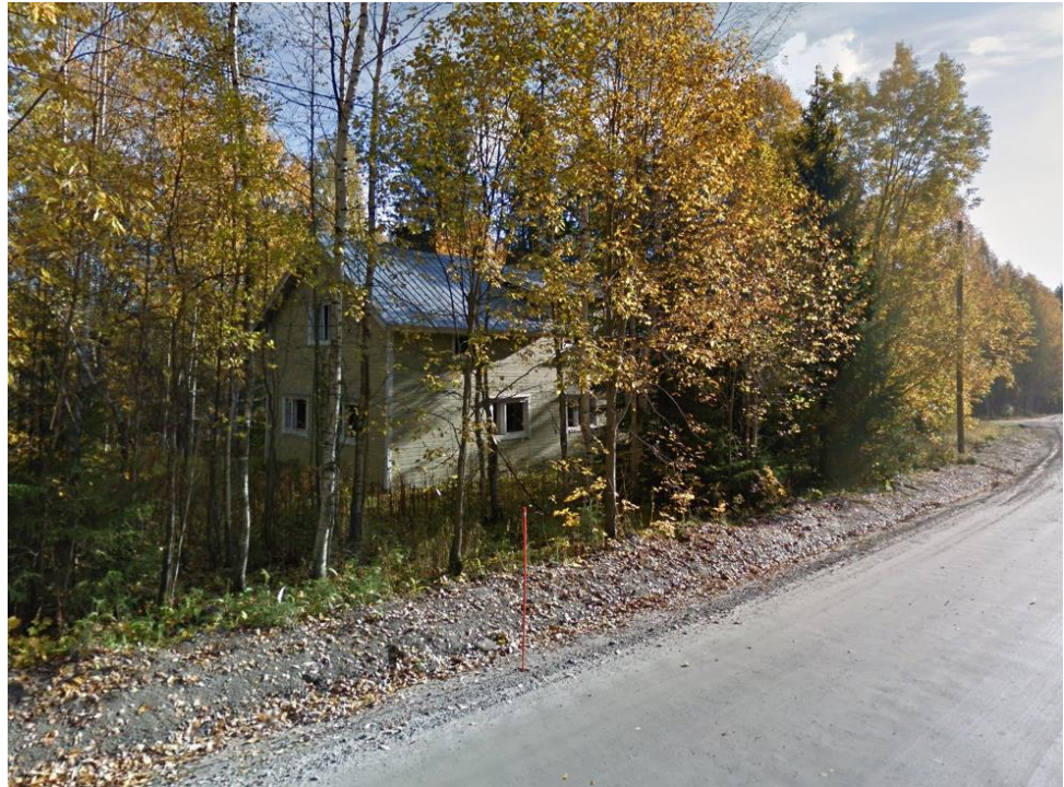
Kuva 5. 2-kerroksinen asumaton asuinrakennus Yläviekintie 1:ssä, mikä on valmistunut 1940-luvulla.
