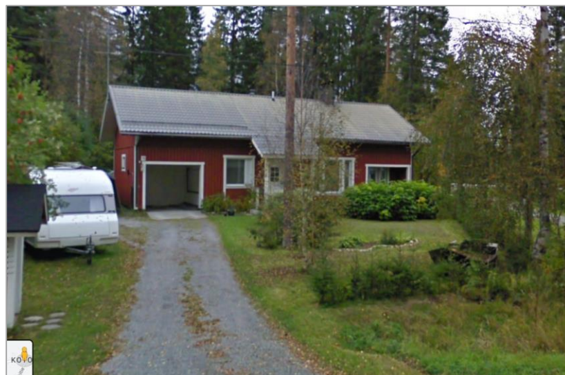
Kuva 20. Kehätie 15 1-kerroksinen asuinrakennus punaisella laudoituksella, mikä on valmistunut vuonna 1990.
