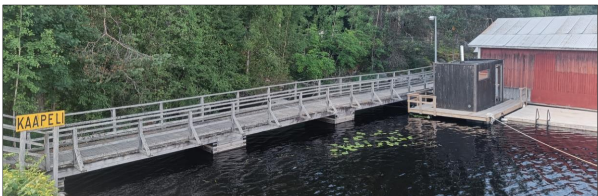
Kuva 17. Puurakenteinen kävelytasanne. Rakenteiden kunnostus käynnistyy syksyllä 2024 (FCG 2024).
