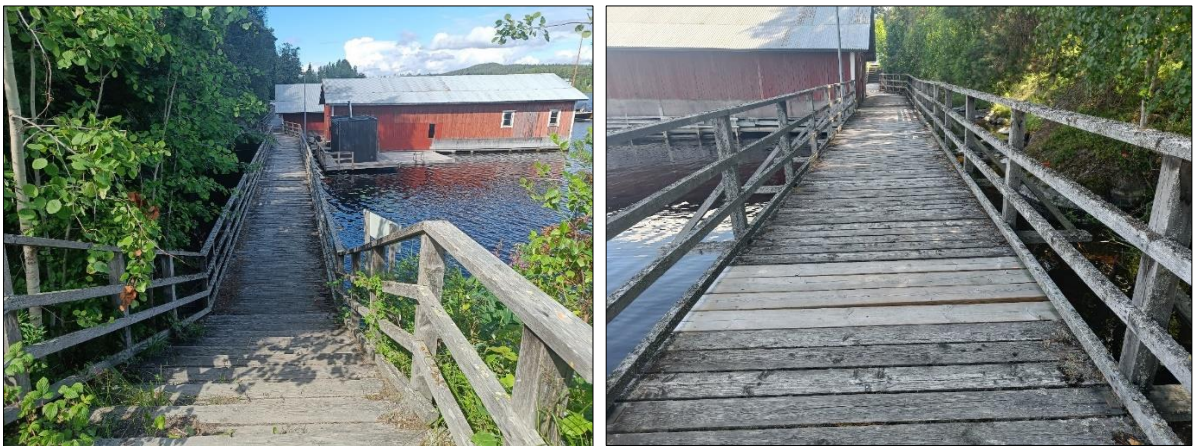
Kuva 39. Kulkuyhteytenä toimiva puutasanne. (FCG 2024).
