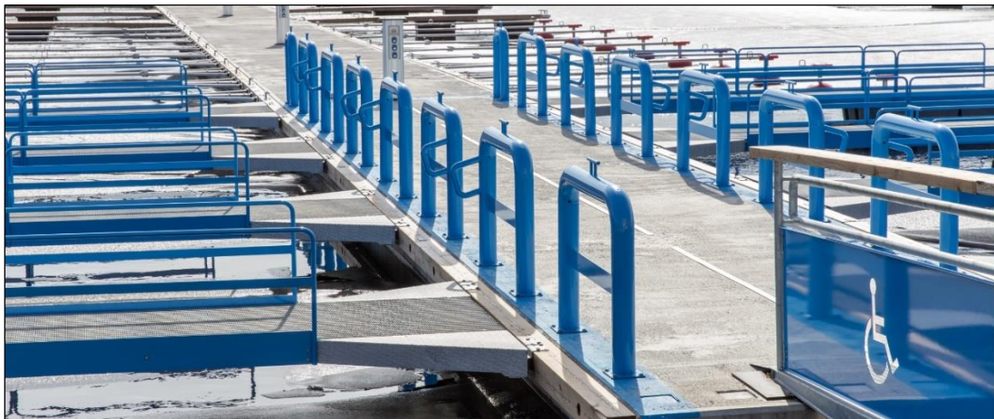
Kuva 32. Naistenlahden venesatama; Puomeja, käyntisilta ja näkövammaisille tarkoitettu ohjausraita.
