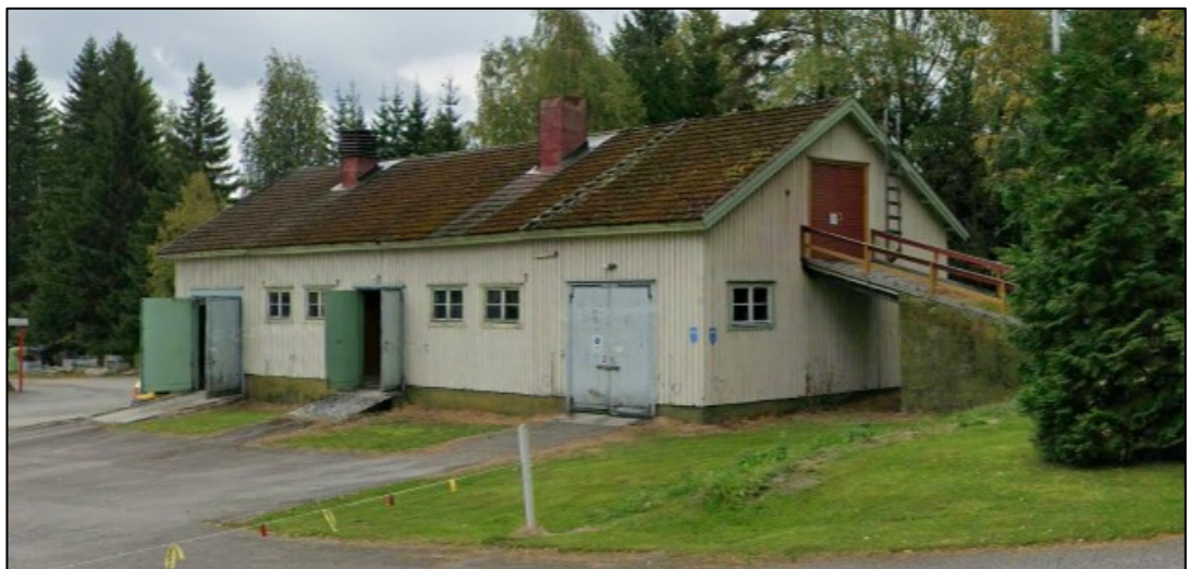
Kuvat 8 ja 9 vanhoista puolustusvoimien rakennuksista: rantasauna ja varastorakennuksesta, joilla on voimassa olevassa kaavassa sr-2 merkintä.
