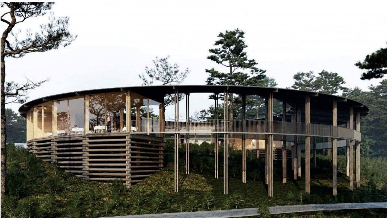
Kuva 13. Huipun kortteli 27. Päärakennus alarinteen suunnasta.
