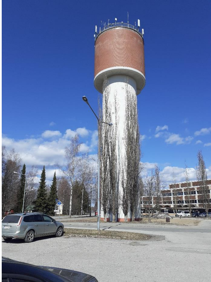
Kuva 3. Lieksan vesitorni (Kuva © Lieksan kaupunki).
