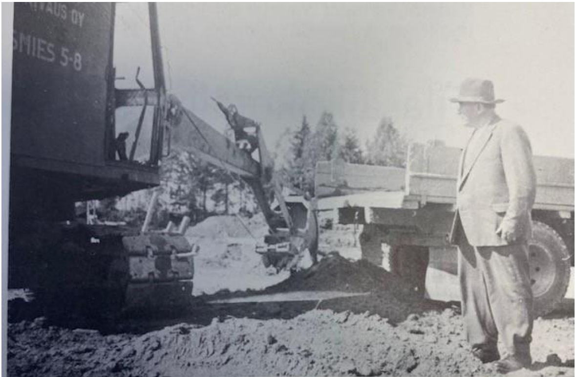
"Lotman Paavo" (Paavo Kinnunen), juustolan rakentamishankkeen puolestapuhuja toteamassa rakennustyön aloittamista kesällä 1961.
