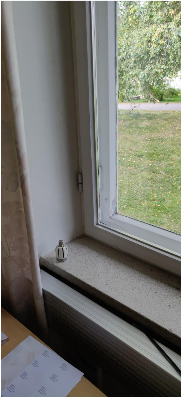
Kuva: Rakennuksen ikkunarakenteiden liitokset ulkoseinään kuvattuna kesällä 2021. Lähde: Aavakax Oy:n arkisto.
