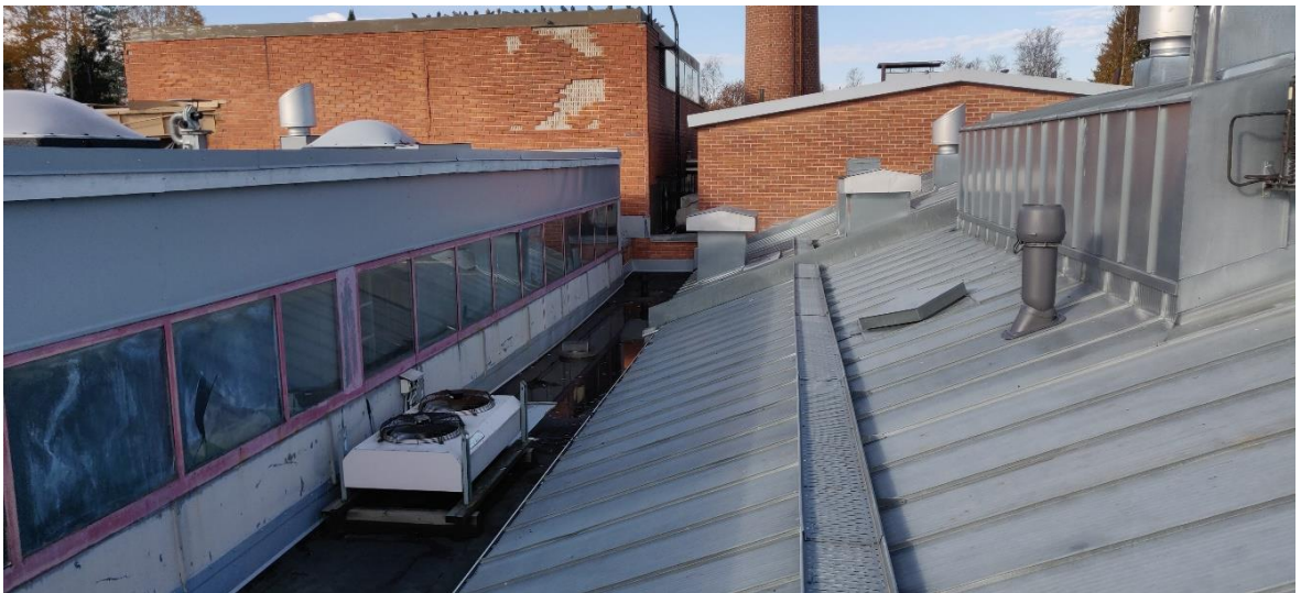
Kuva. Rakennuksen vesikaton liittymärakenteita kuvattuna syksyllä 2021. Oikealla myymälä osa, vasemmalla kylmä varasto ja edessä punatiiliverhotut lämpölaitoksen rakennukset. Aavakax
