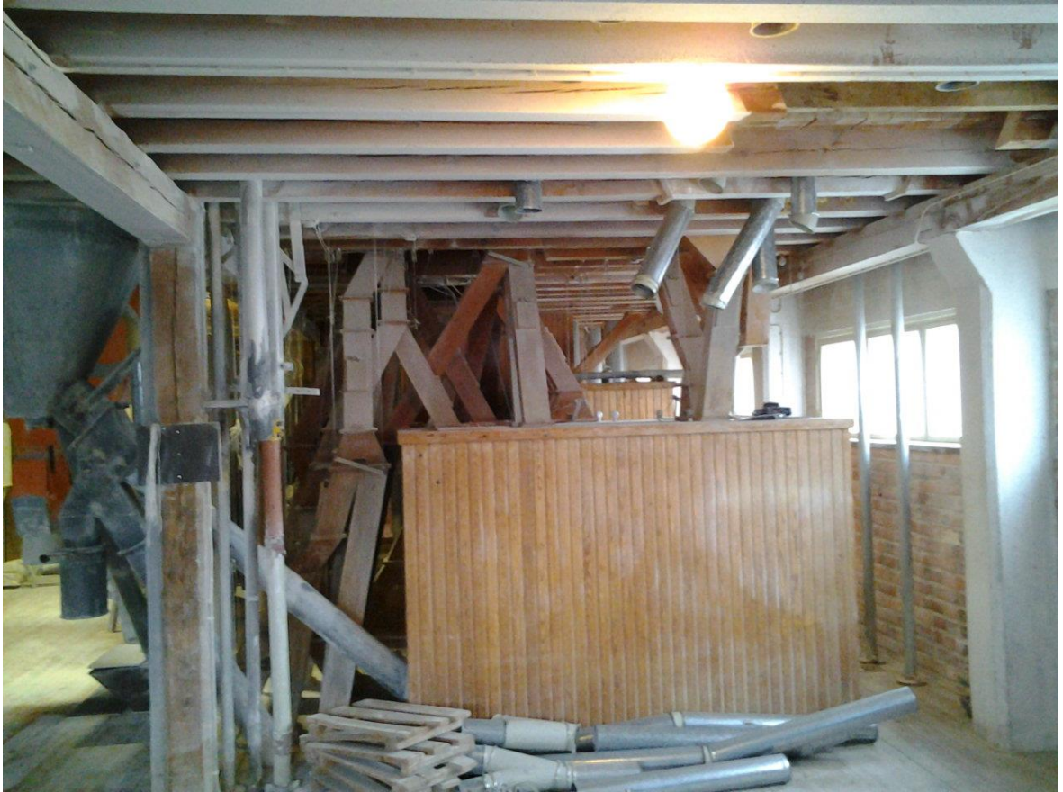
Kuva: Myllyn tuotantotilat. Kuvassa näkyy välipohjarakenteina olevat kantavat puu- ja hirsirakenteet, hirsipilareita sekä lattian puurakenteet. Lähde: Aavakax Oy:n arkisto.
