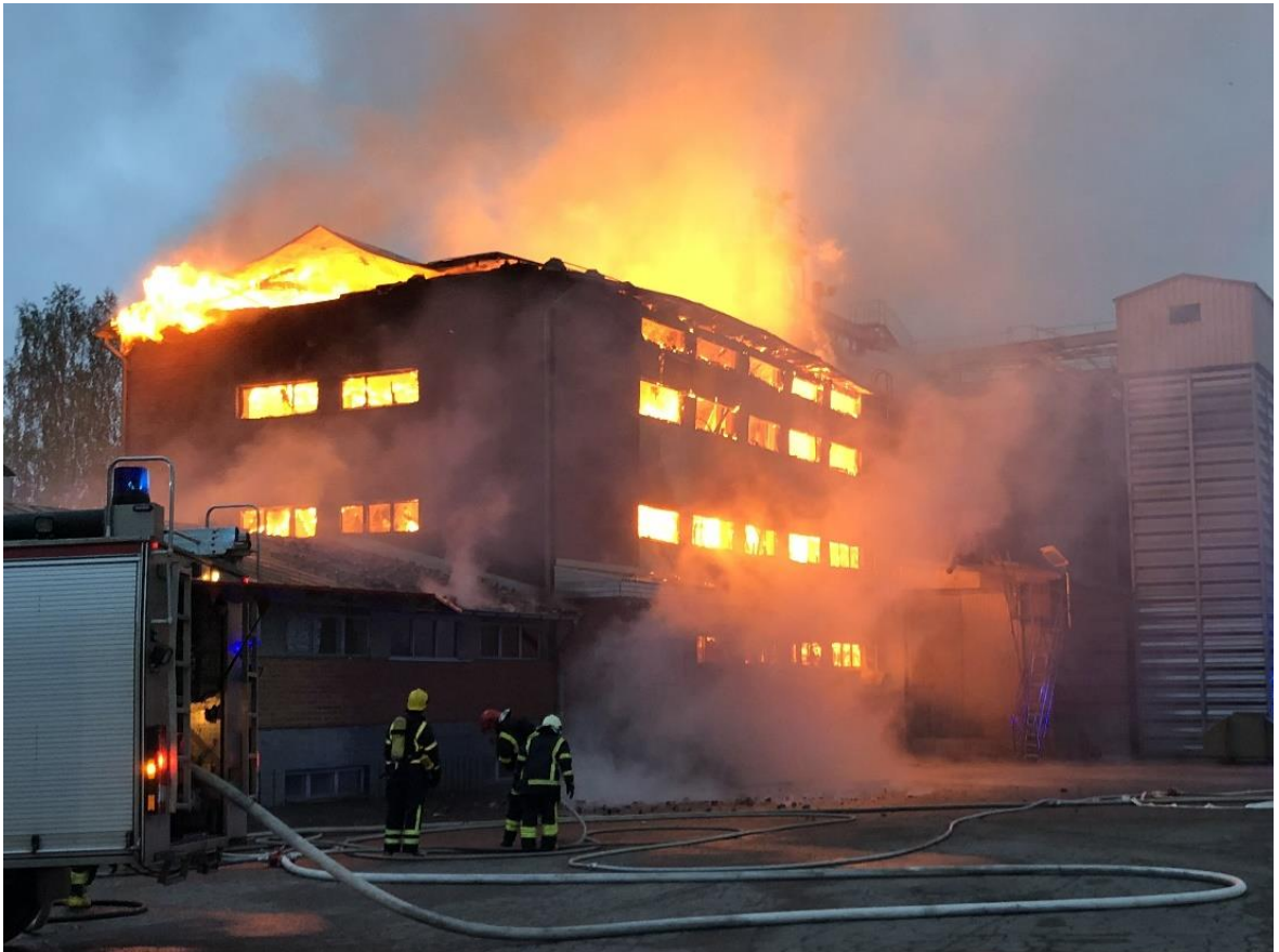
Kuva: Myllyrakennus tuhoutui tulipalossa 5.6.2020. Rakennuksen rauniot purettiin syksyllä 2020 ja osin tulipalossa vaurioituneet siilot helmikuussa 2021. Lähde: Aavakax Oy:n arkisto.
