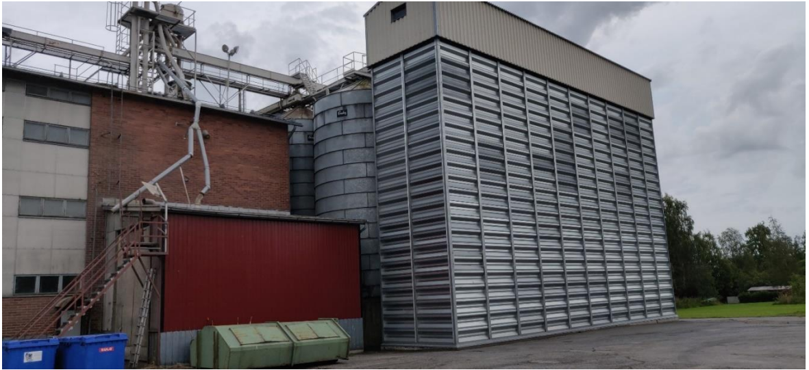
Kuva: Myllyrakennus 2019 siilojen kohdalta. Lähde: Aavakax Oy:n arkisto.
